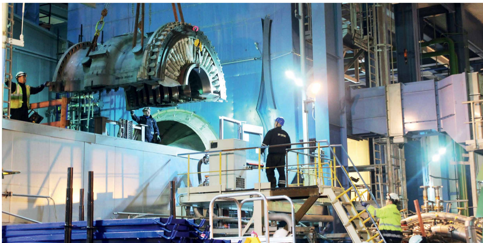
Монтаж крышки корпуса компрессора газовой турбины
