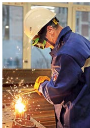
Газорезчик готовит образцы для последующей обработки кромок и сварки
