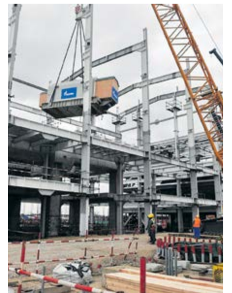
Установка генератора паровой турбины на фундамент
