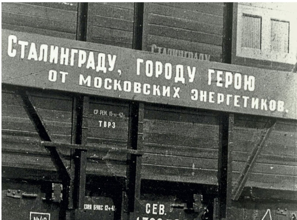
Изготовленный на ТЭЦ-12 энергопоезд перед отправкой в Сталинград
