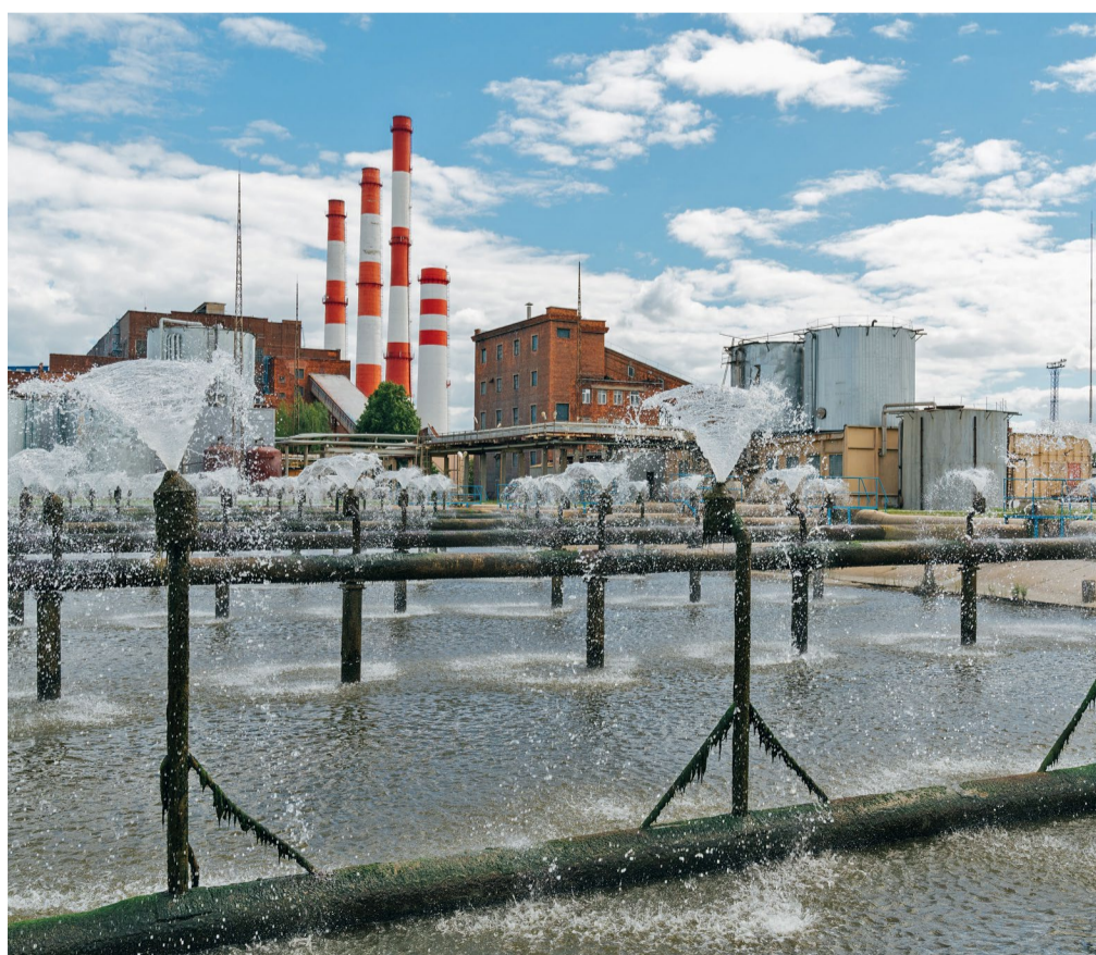
ТЭЦ-17 – единственная электростанция Мосэнерго, где для охлаждения циркуляционной воды используется брызгальный бассейн
