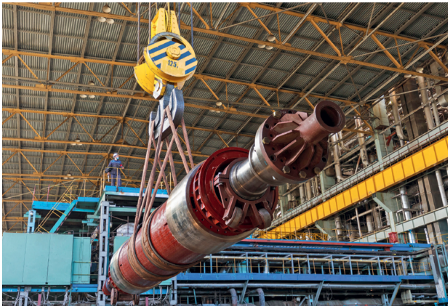
Ремонт ротора генератора ТГ-11А, работающего в составе энергоблока № 11 ПГУ-450Т ТЭЦ-21
