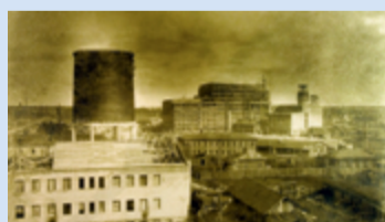
Строительство ТЭЦ-11, 1934 год
