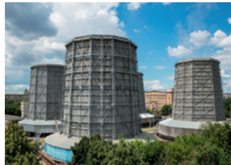
ТЭЦ-11 – единственная электростанция Мосэнерго с каркасно-обшивными башенными градирнями
