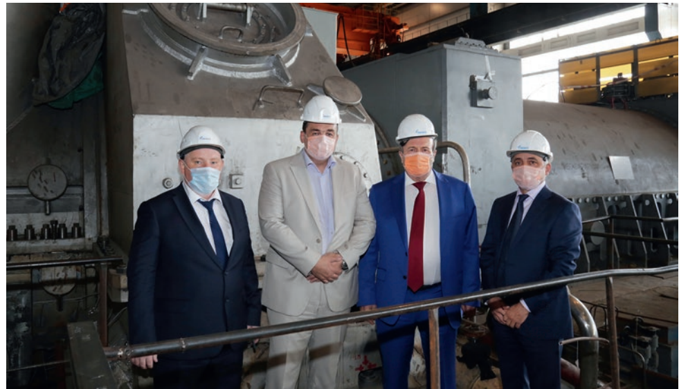
На площадке реконструкции энергоблока № 9
