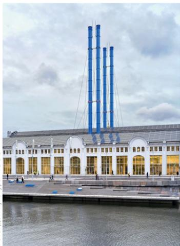
Установленные над зданием ГЭС-2 70-метровые трубы служат для забора и очистки воздуха
