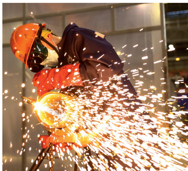
В проведении сварочных работ конкуренцию Мосэнерго не смогли составить даже специалисты ТЭР
