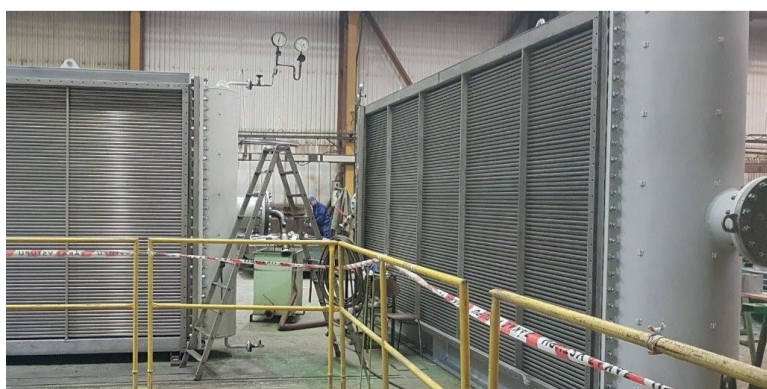
Секции теплоутилизатора в процессе монтажа на площадке РТС «Курьяново»
