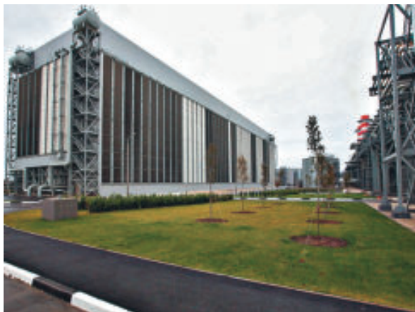
Рис. 12. Сухая вентиляторная градирня GEA
