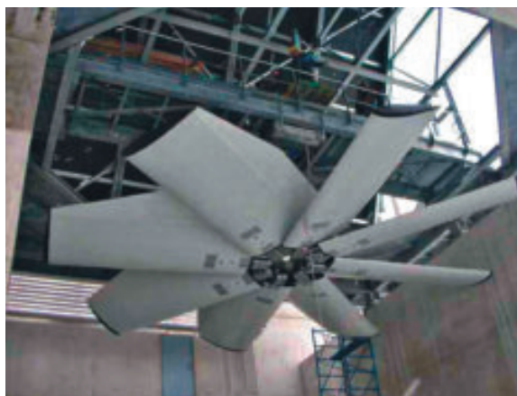
Рис. 18. Рабочее колесо вентилятора ВКУ поставки SPIG с расширенным профилем лопастей
