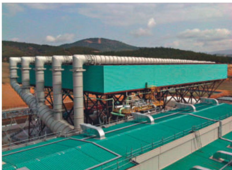
Рис. 9. Воздушно-конденсационная установка к энергоблоку 755 МВт (г. Денизли, Турция)
