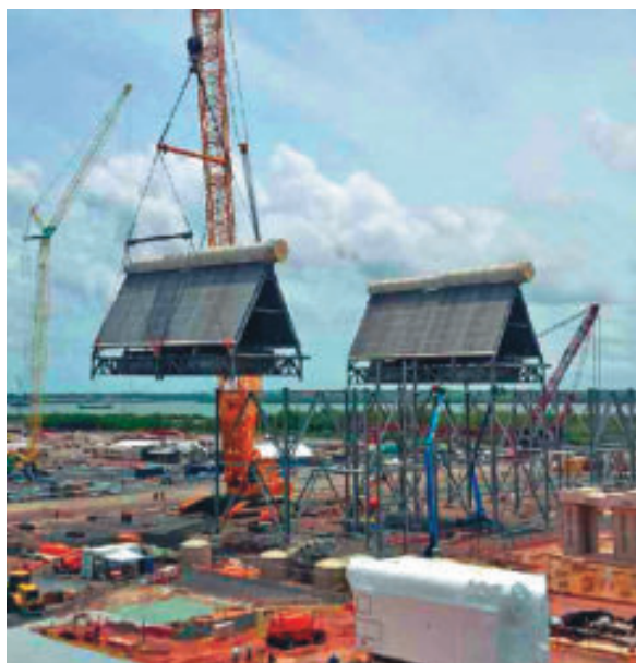
Рис. 22. Монтаж теплообменной секции ВКУ
