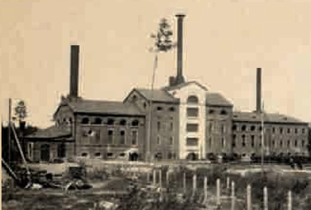
Общий вид временной Шатурской электростанции
