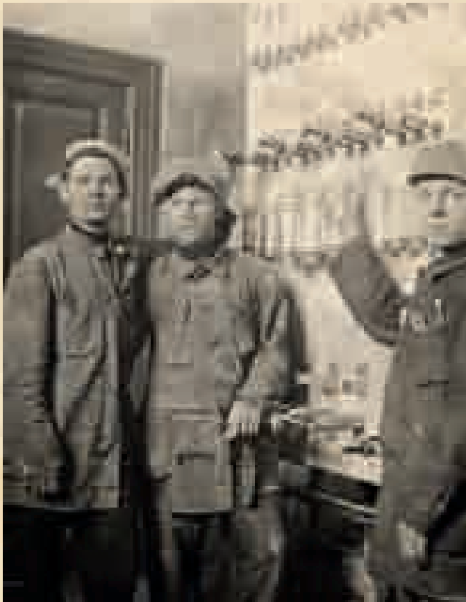
Монтеры электростанции в подмосковном фабричном городе Орехово-Зуеве, 1928 год
