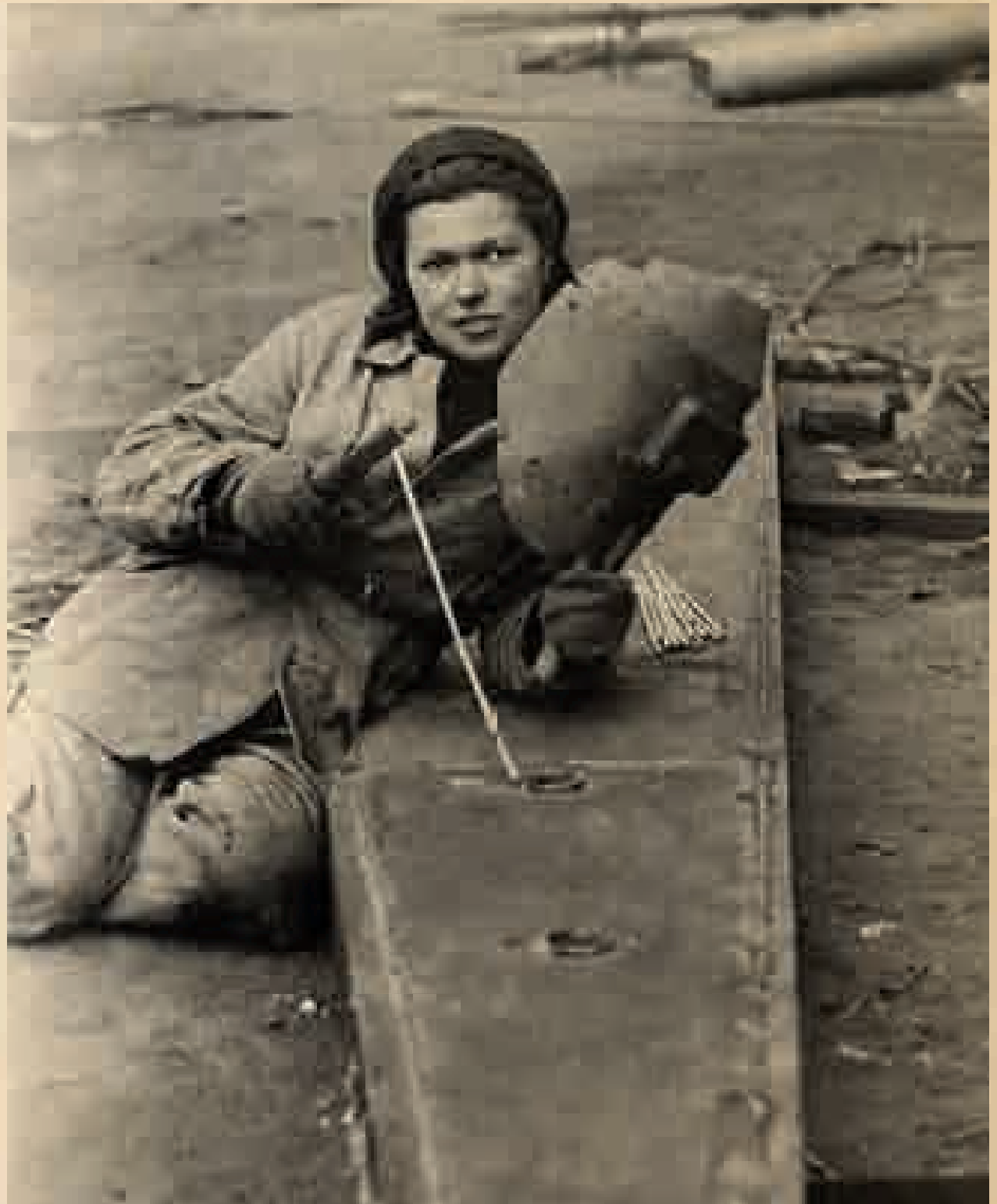
Сварочные работы на топливоподаче ТЭЦ-8, 1940-е годы
