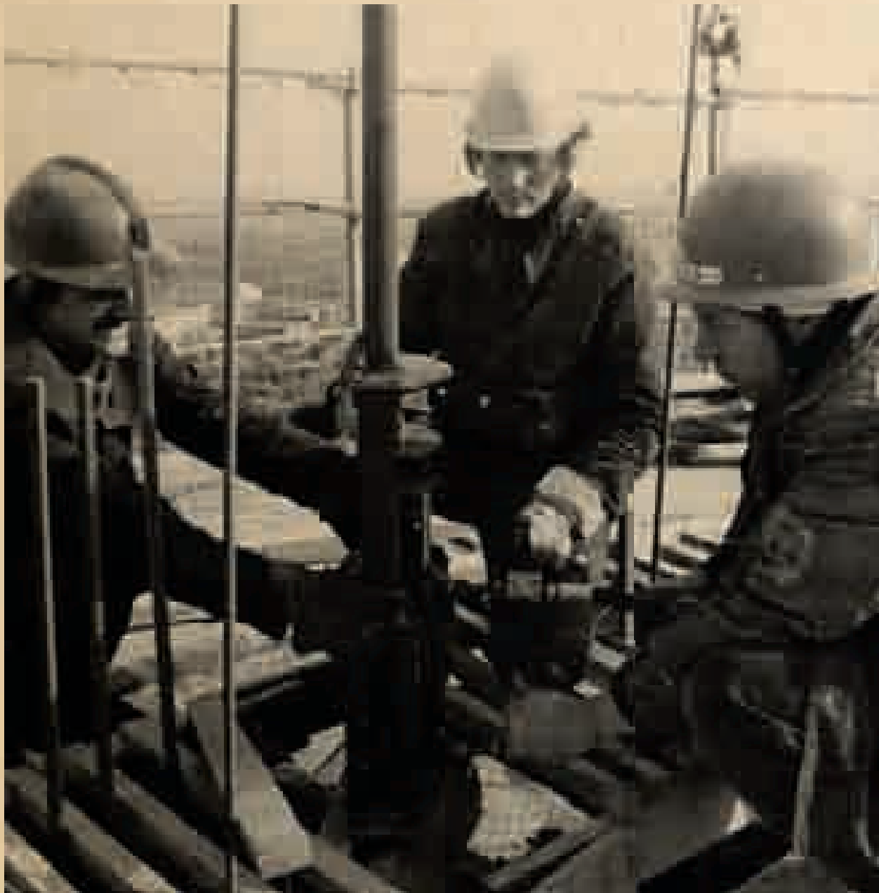
Строительство ТЭЦ-25, 1970-е годы
