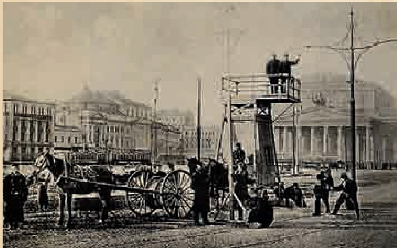
Монтаж рабочего провода на Театральной площади, начало XX века
