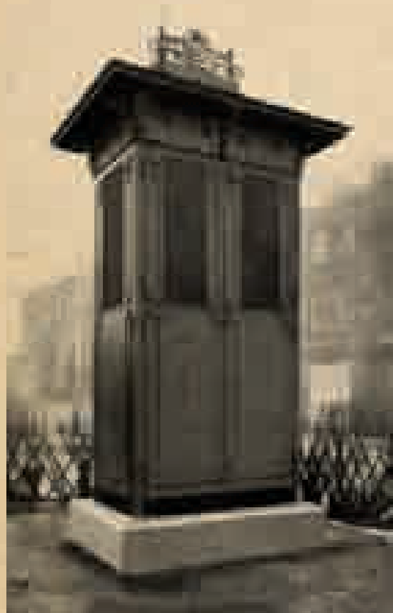
Будка для двух трансформаторов, 1910 год
