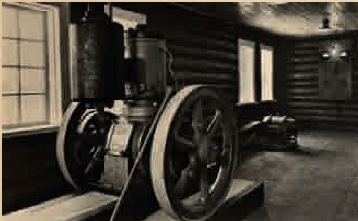
Село Кашино (Московская область). Внутренний вид одной из первых в стране сельских электростанций, 1920 год
