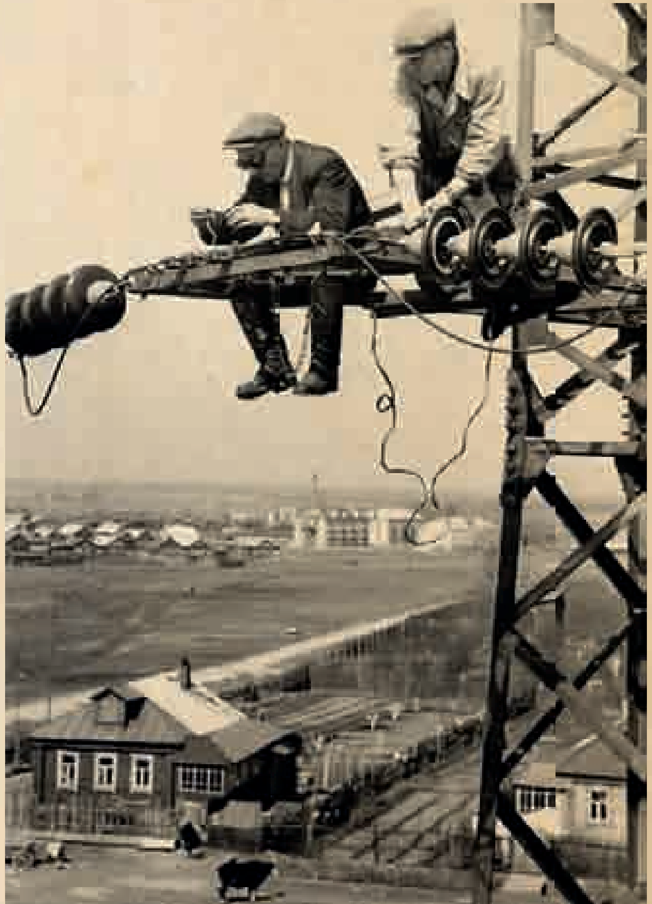
Электрификация сельских районов (термитная сварка проводов), 1950-е годы
