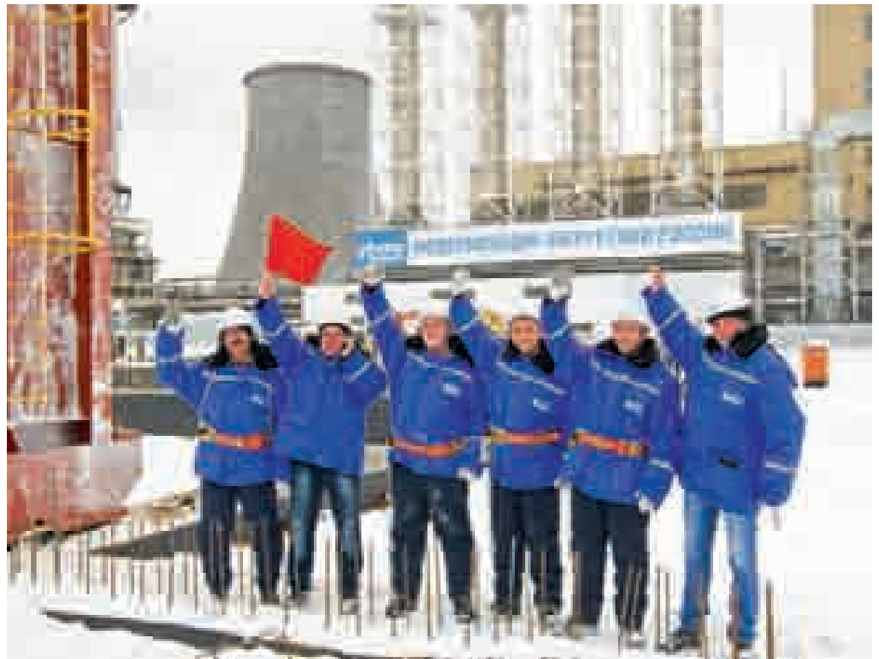
Начало строительства энергоблока ПГУ-420 ТЭЦ-16, 2011 год
