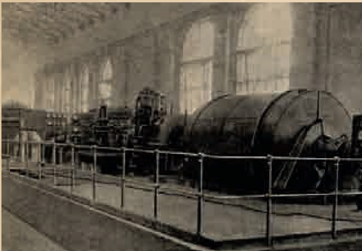
Теплофикационный турбогенератор ЛМЗ мощностью 12 МВт на ГЭС-1, 1933 год
