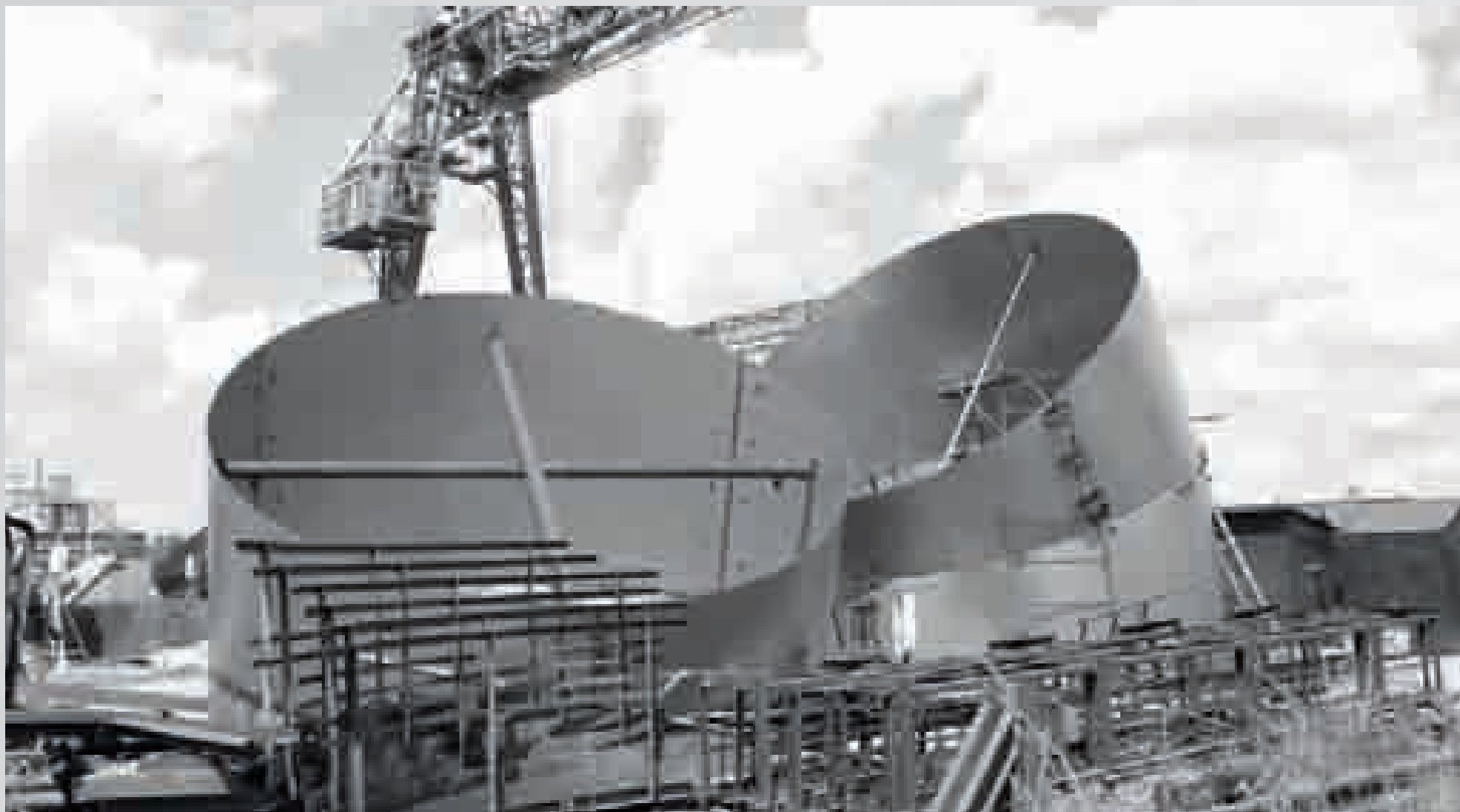
Площадка строительства ПГУ-425 ТЭЦ-21
