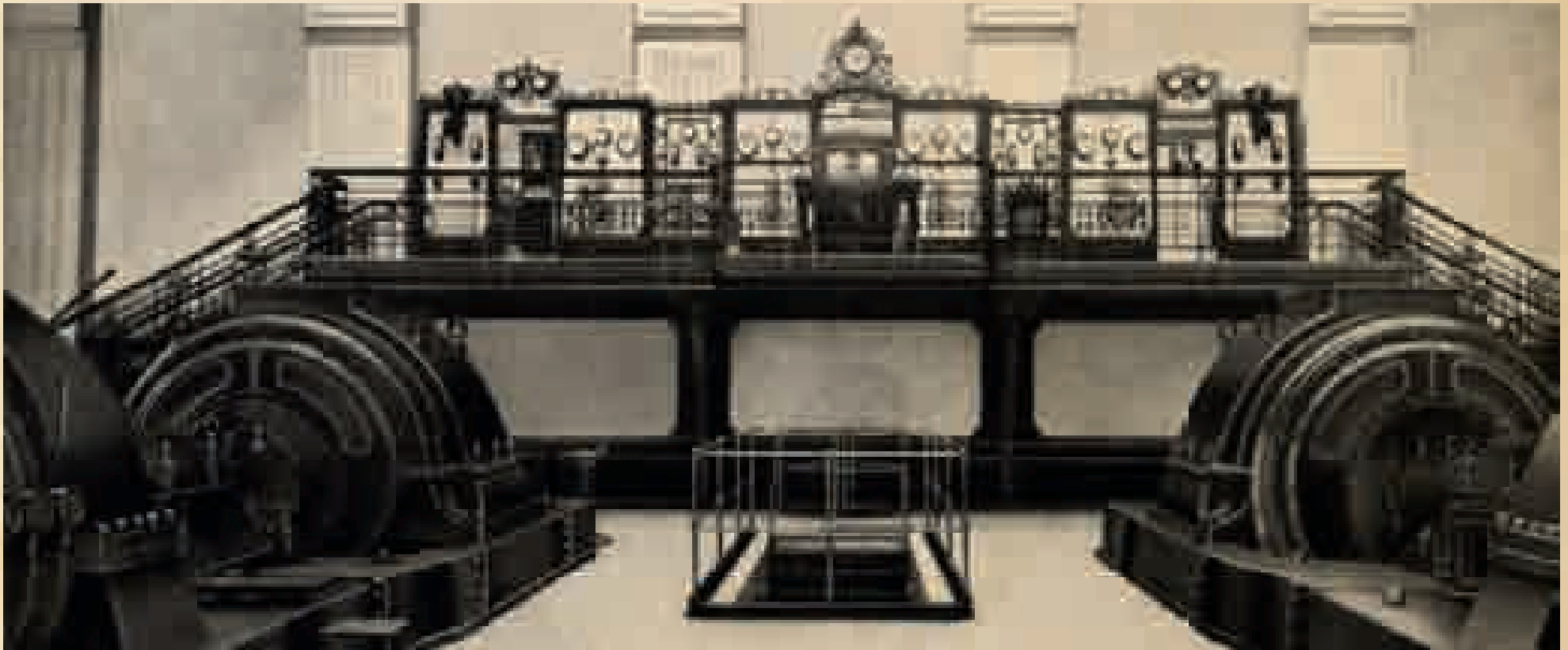
Распределительный щит Раушской электростанции, 1904 год
