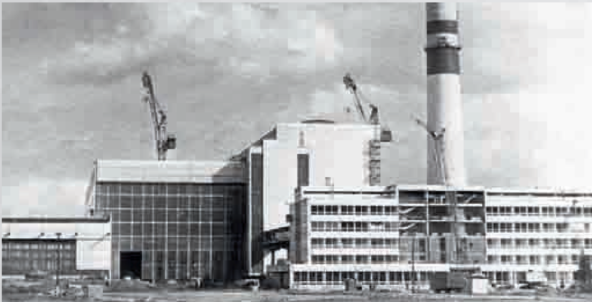
Строительство ТЭЦ-27, 1991 год
