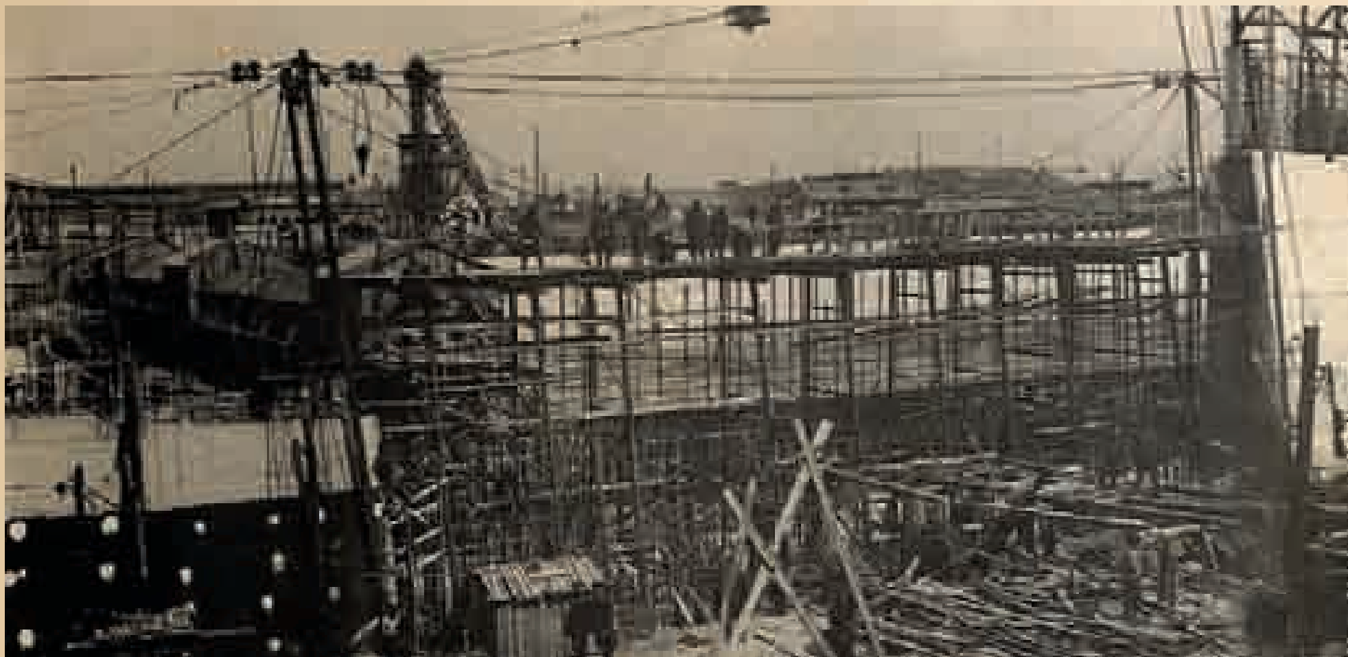
Строительство Угличского гидроузла, конец 1930-х годов
