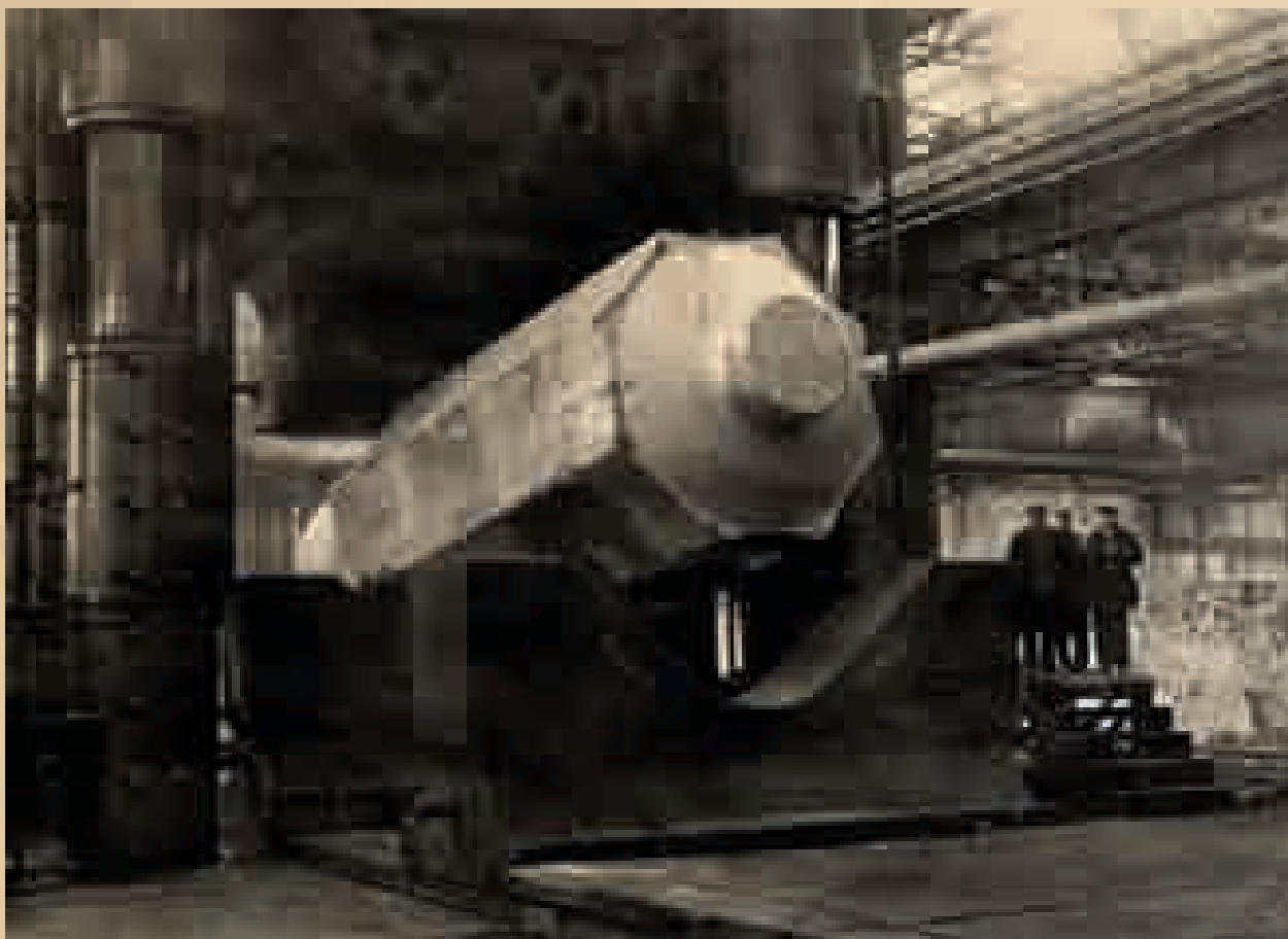
Рыбинская ГЭС, заготовка для вала гидрогенератора № 1 под прессом, 1941 год
