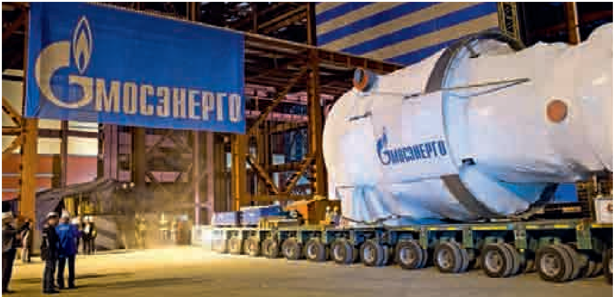
Доставка газовой турбины на площадку строительства ПГУ-420 ТЭЦ-16, 2012 год
