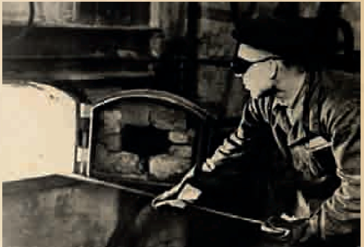
Расщуровка кускового торфа, Шатурская ГРЭС
