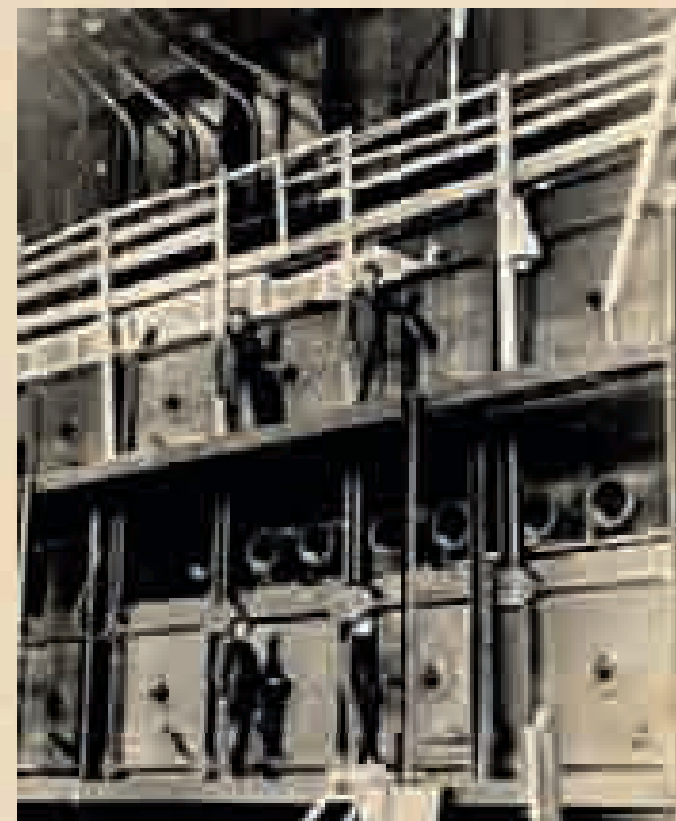
Монтаж оборудования ТЭЦ-11, 1930-е годы
