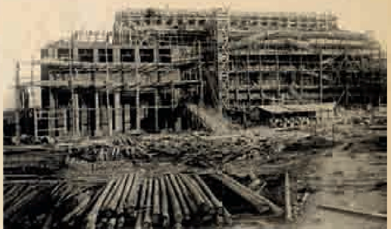
Строительство главного корпуса Каширской ГРЭС, 1920 год
