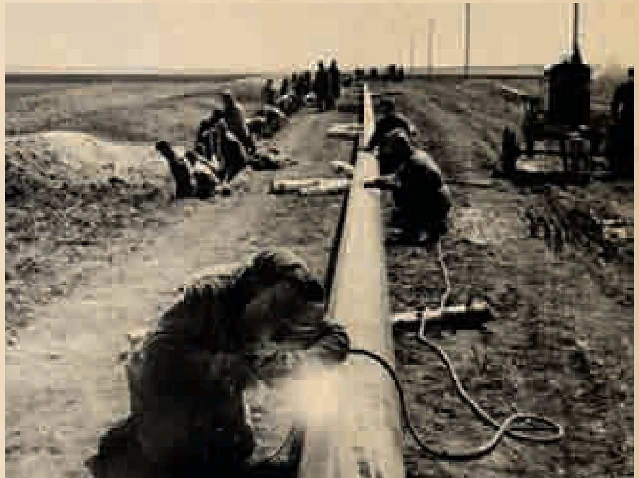
Прокладка газопровода Саратов – Москва
