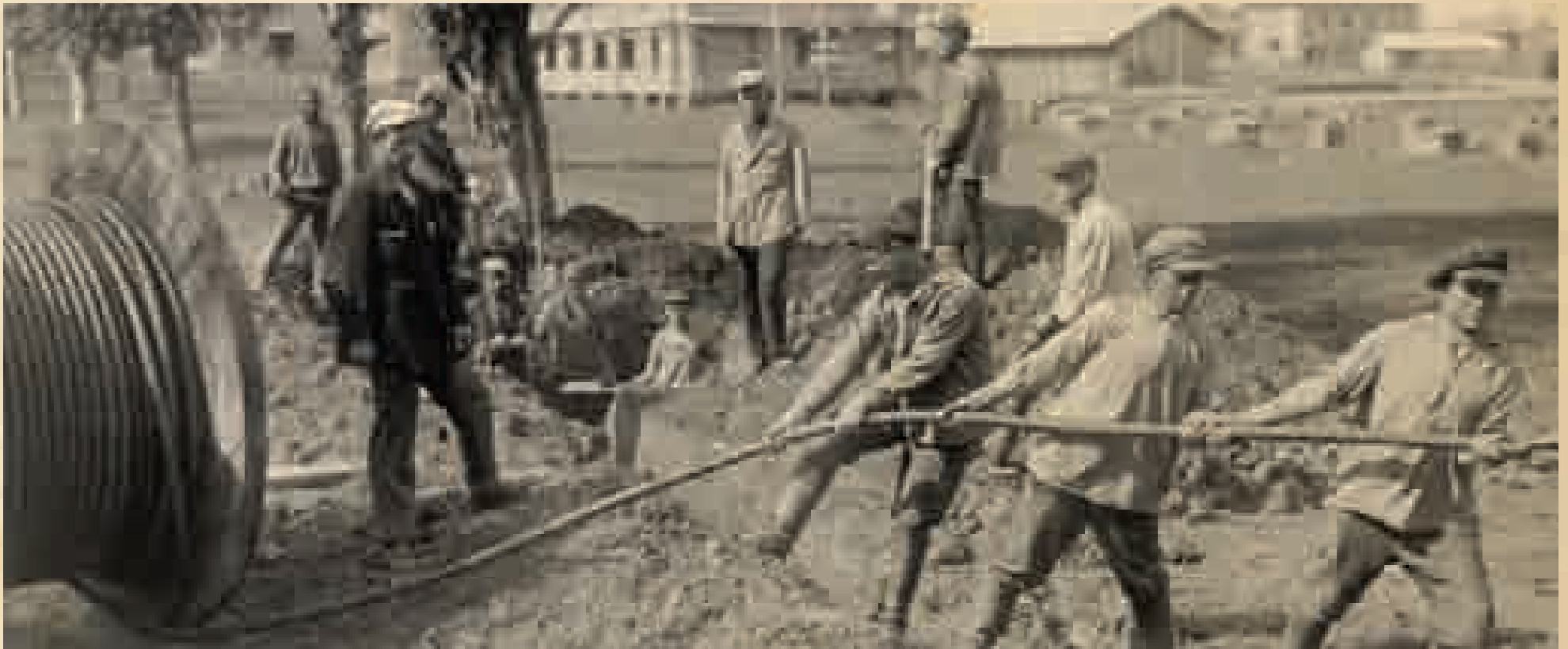
Прокладка электрокабеля в поселке Октябрьском, 1931 год
