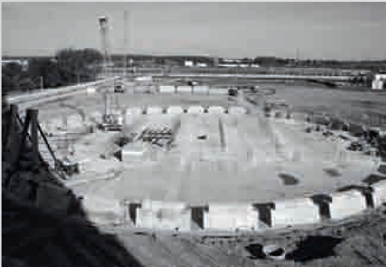
Строительство градирни на ТЭЦ-27, 2006 год
