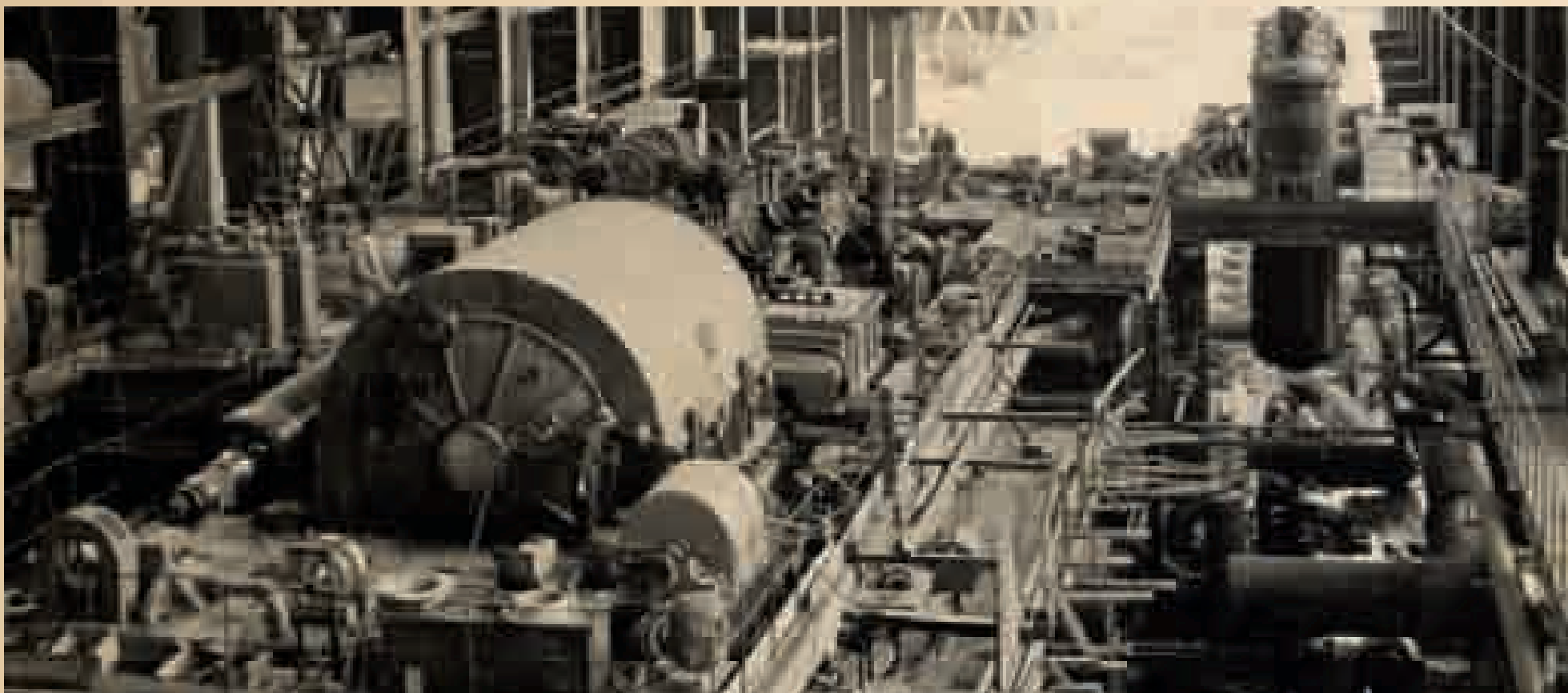
Монтаж турбины ТЭЦ-16, 1960-е годы
