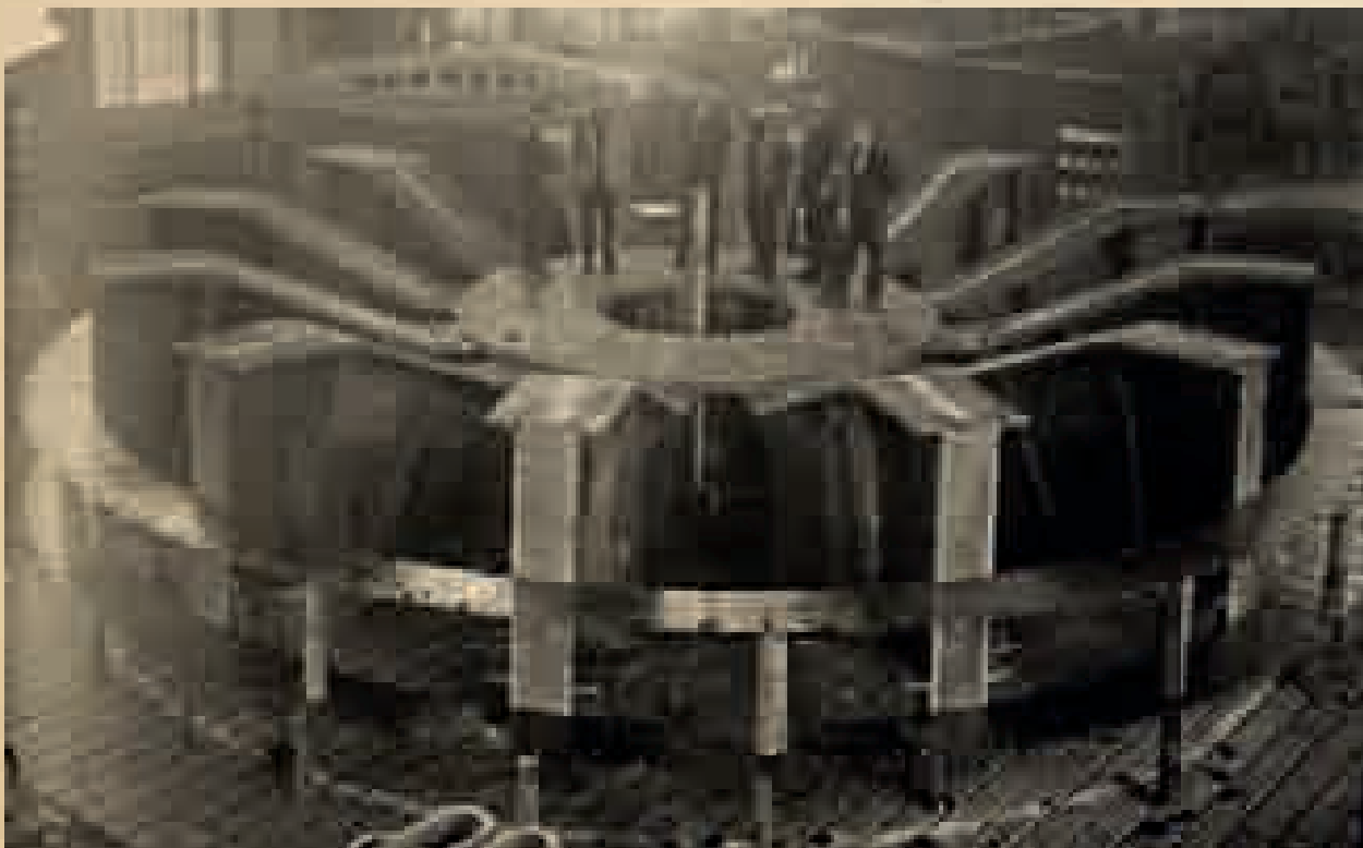
Рыбинская ГЭС, сборка ротора гидротурбины, 1941 год
