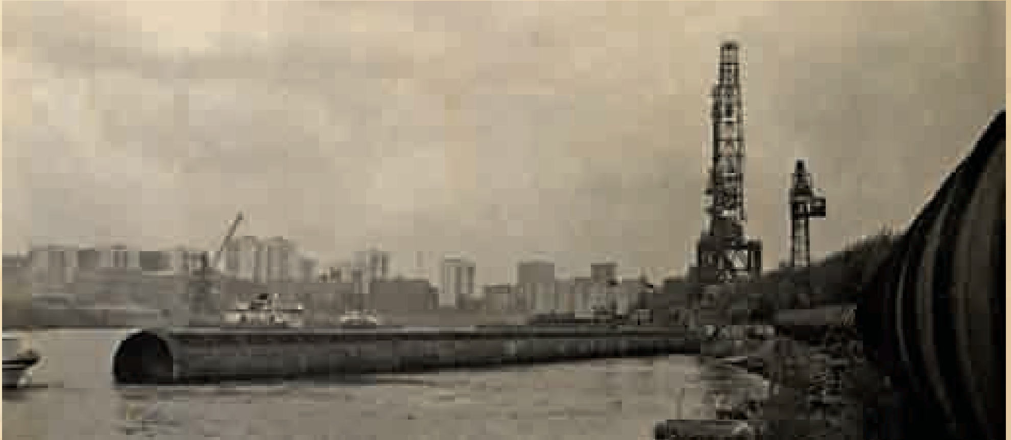
Металлический тоннель (дюкер)
