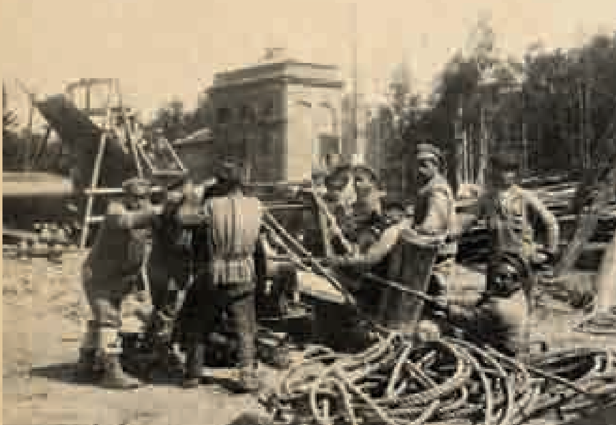
Строительство электростанции в Шатуре, 1920 год
