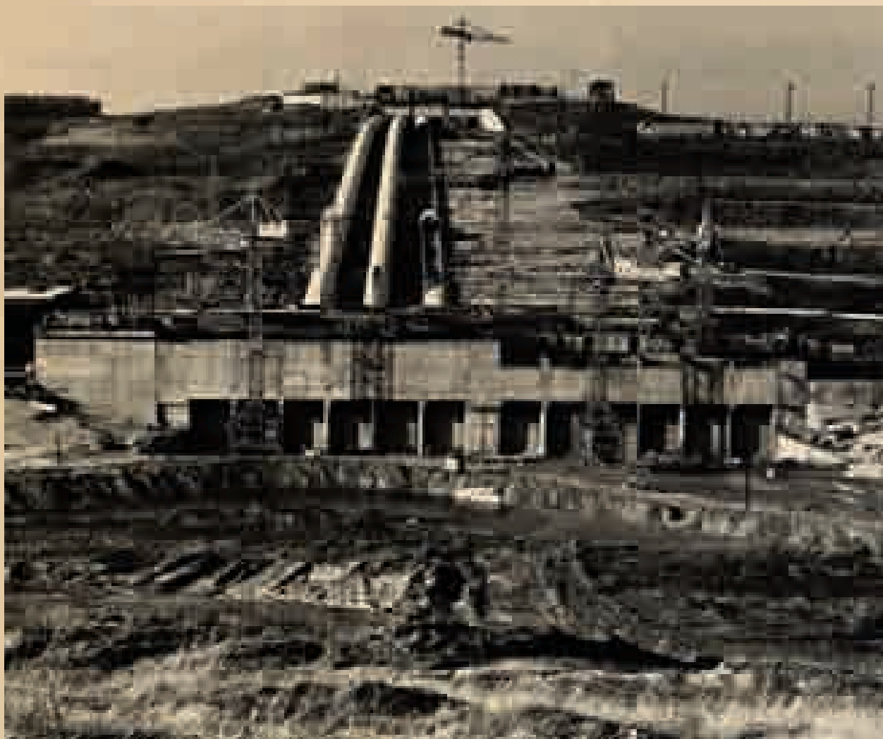
Загорская ГАЭС, котлован, 1986 год
