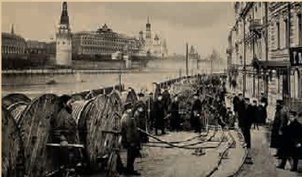
Прокладка кабеля по Софийской набережной, 1912 год
