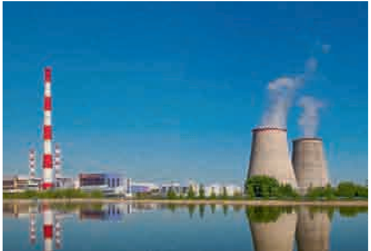
Самая экологически чистая электростанция в Европе – ТЭЦ-27
