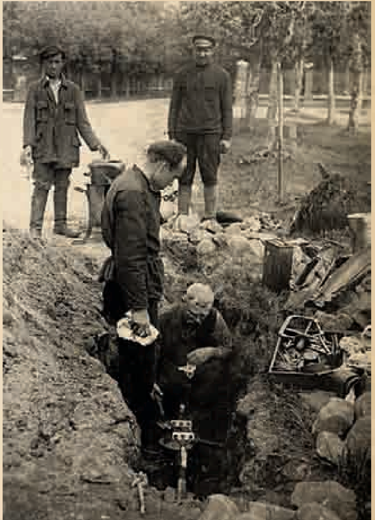
Закладка электрической муфты, конец 1920-х годов
