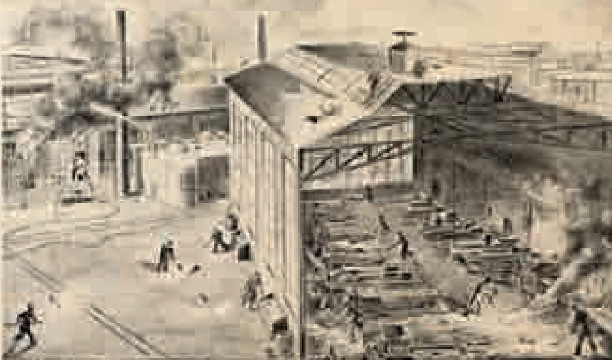
Весь завод до основания разрушен. Загоревшиеся материалы, оборудование и инструменты разбросаны тучи зажигательных и ракетных бомб на территории завода.
