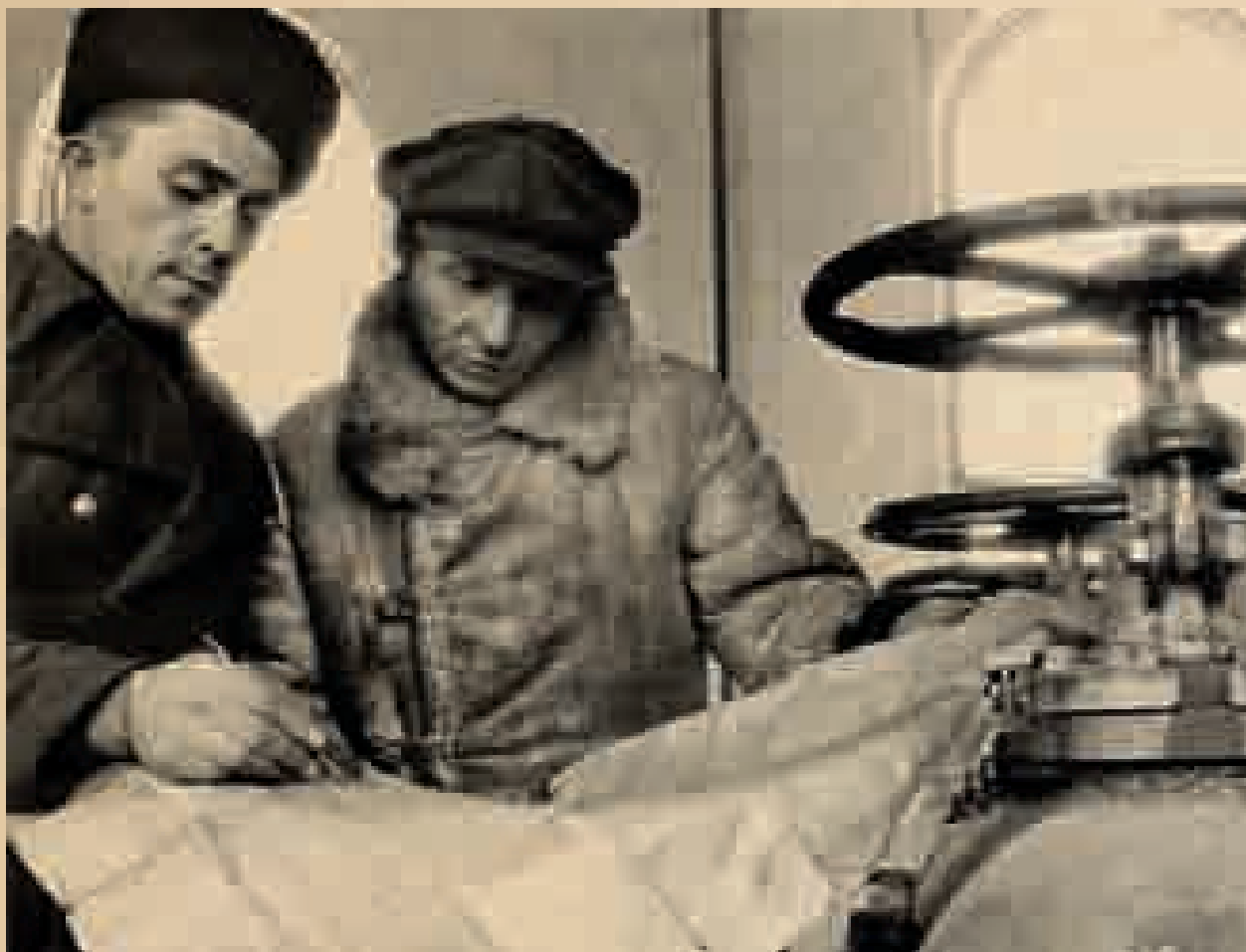
Согласование работ на газораспределительной станции № 1 газопровода Саратов – Москва в Московской области, 1946 год
