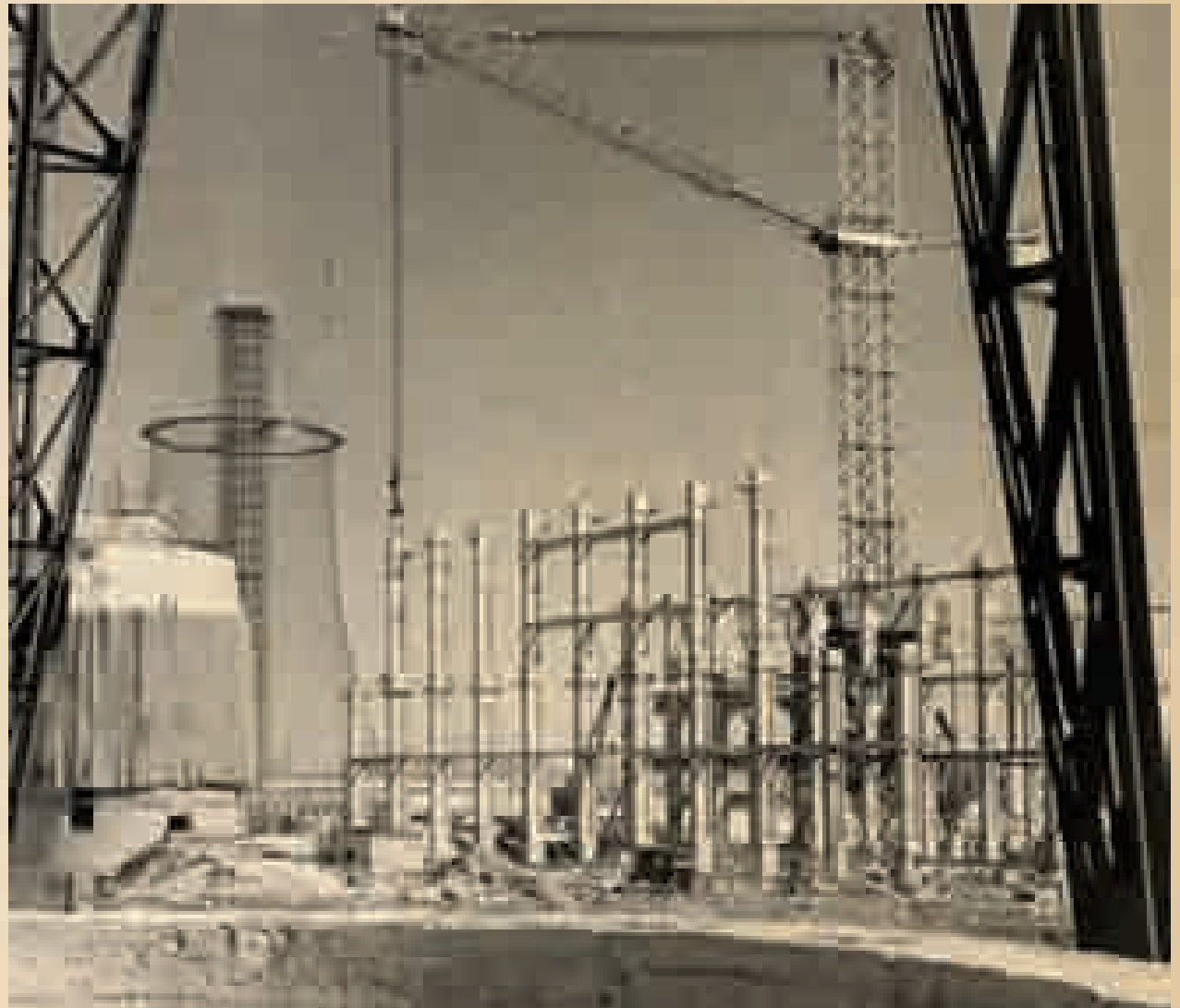
Строительство главного корпуса, трубы и градирни ТЭЦ-21, 1962 год
