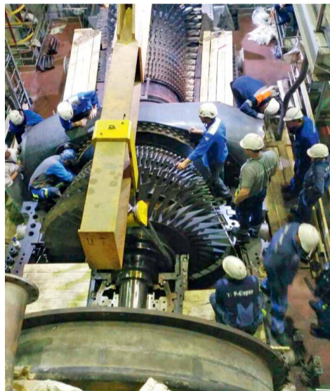
Вывод ротора газовой турбины
