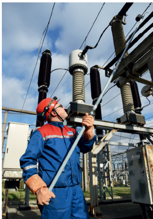
Проверка напряжения на ОРУ 110 кВ ТЭЦ-23
