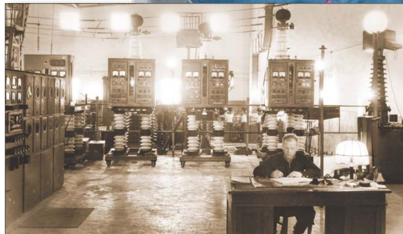
Год 1956. Контроль параметров на подстанции
