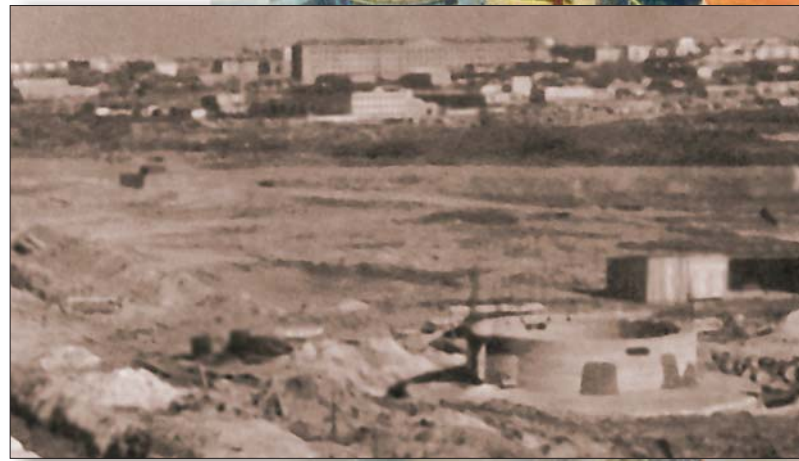
1960-е годы. Начало строительства теплоэлектростанции (ТЭЦ-23)
