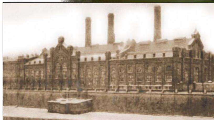
Год 1910. Здание ГЭС-1
