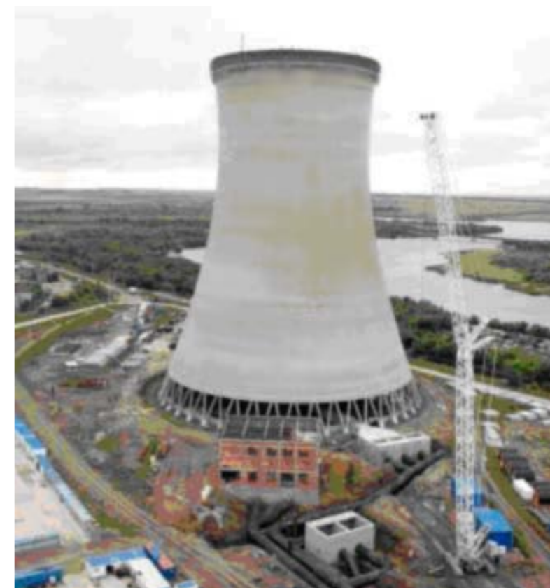
Рис. 23. Бетонирование корпуса башенной градирни на Троицкой ГРЭС
