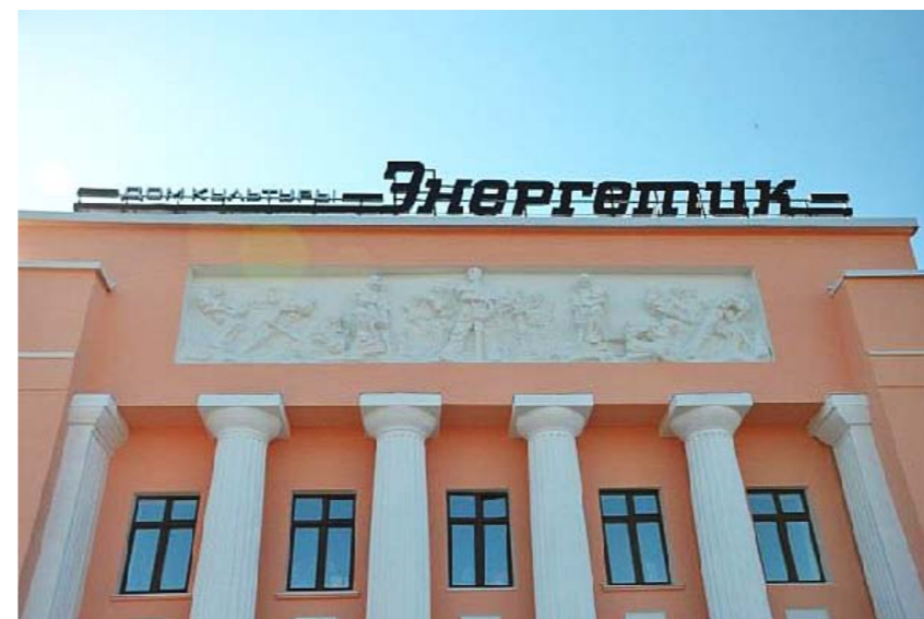
Рис. 82. Дом культуры «Энергетик», п. Мурмаши, Мурманская обл.
