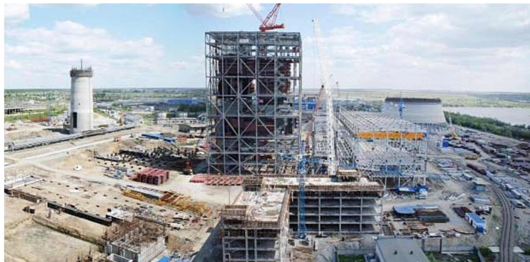
Рис. 33. Строительство нового пылеугольного энергоблока на Троицкой ГРЭС
