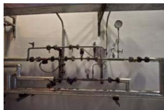
Рис. 27. Техническое оборудование ТЭЦ-26
