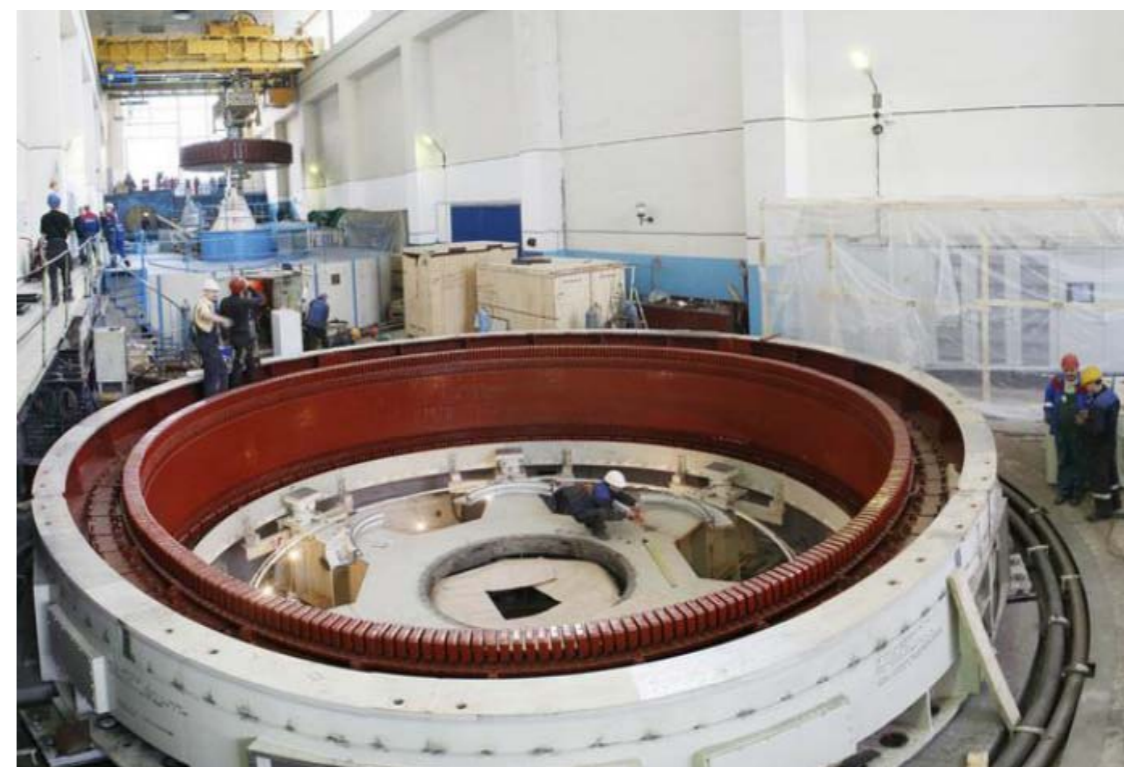
Рис. 26. Установка ротора гидроагрегата № 3 на Лесогорской ГЭС
