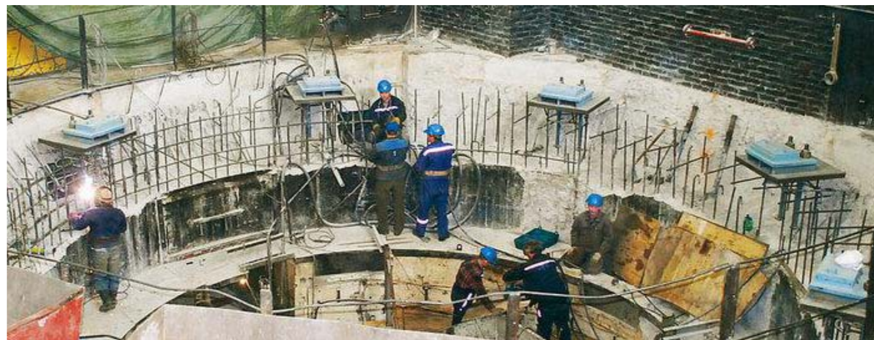
Рис. 25. Монтаж гидроагрегата № 3 на Лесогорской ГЭС
