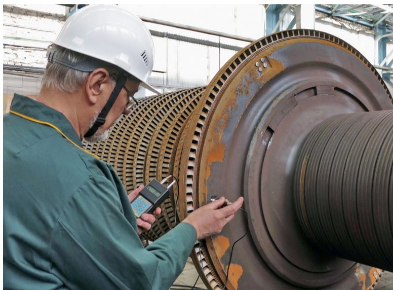
Контроль металла ротора высокого давления паровой турбины
