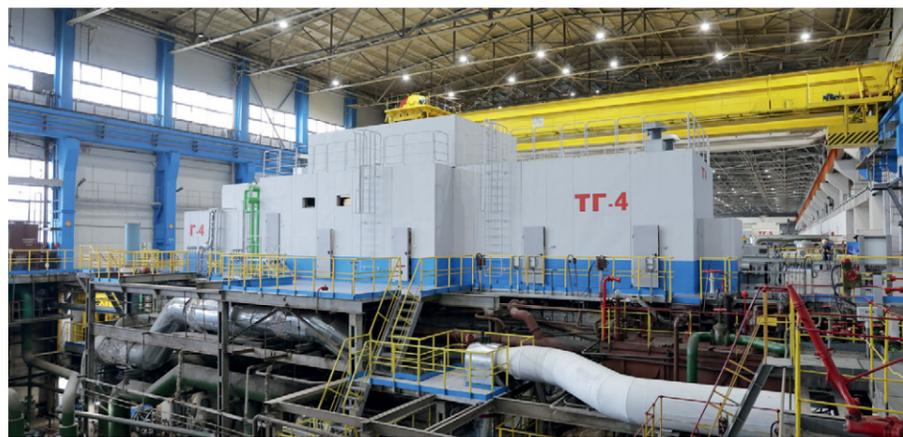
В результате модернизации установленная электрическая мощность ТГ-4 ТЭЦ-23 увеличена с 100 до 110 МВт, тепловая – с 160 до 175 Гкал/ч
