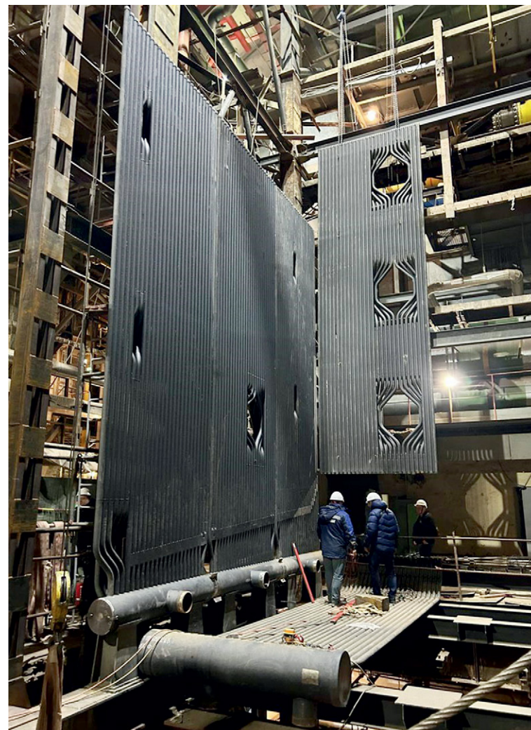
Монтаж топочной части водогрейного котла № 5 ГЭС-1
