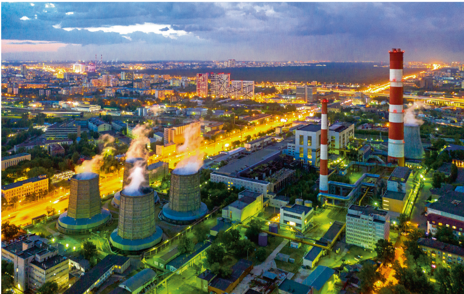
ТЭЦ-11 обеспечивает энергоснабжение ряда районов востока и юго-востока Москвы
