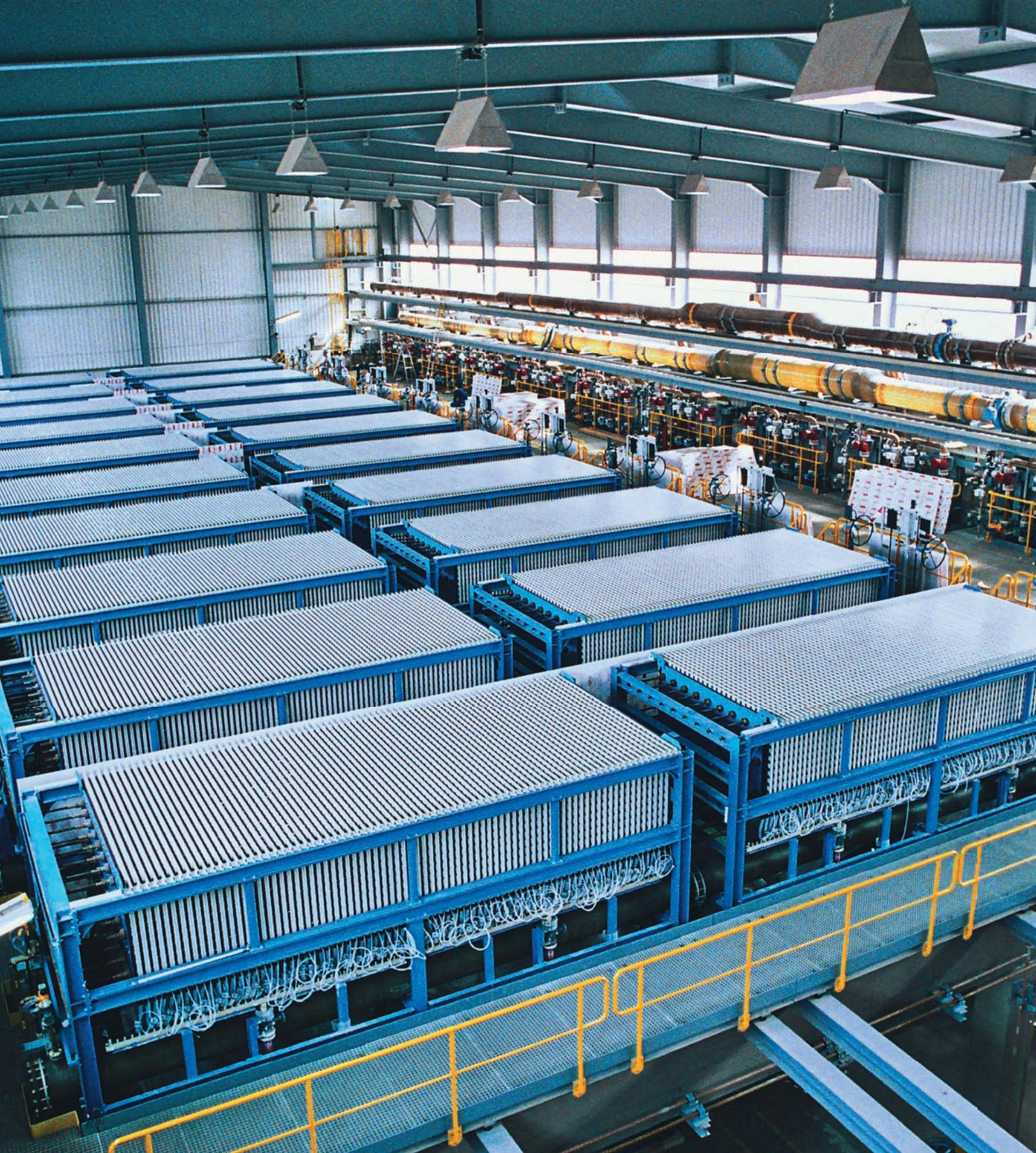
В ТОПЛИВНЫХ ЭЛЕМЕНТАХ РЕАЛИЗУЕТСЯ ПРЯМОЙ ПРОЦЕСС ПРЕОБРАЗОВАНИЯ ХИМИЧЕСКОЙ ЭНЕРГИИ ВОДОРОДА В ЭЛЕКТРИЧЕСКУЮ ЭНЕРГИЮ И ТЕПЛО
