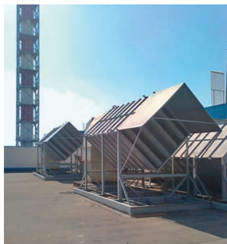
Рис. 3.7. Размещение глушителей систем вентиляции кожуха ГТУ на крыше станции: а — глушители выхлопа; б — глушители воздухозабора вентиляции ГТУ
