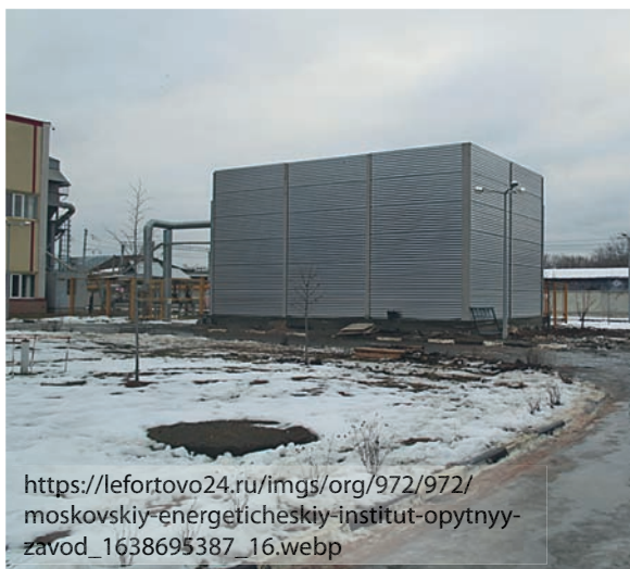
Рис. 3.18. Акустический 7-метровый экран Г-образной формы для снижения шума дожимной компрессорной установки
