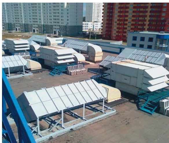
Рис. 3.7. Размещение глушителей систем вентиляции кожуха ГТУ на крыше станции: а — глушители выхлопа; б — глушители воздухозабора вентиляции ГТУ
