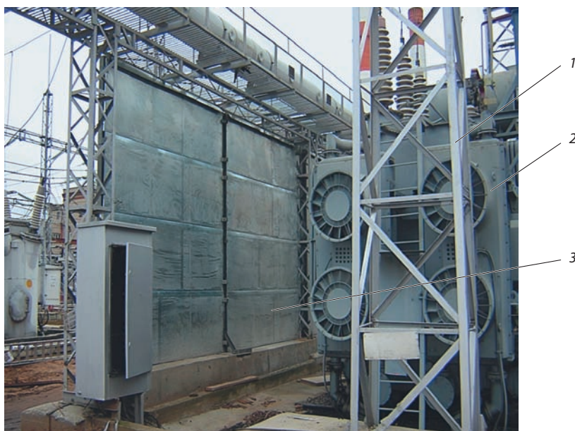
Рис. 3.16. Общий вид секции шумозащитной конструкции СВГ: а — общий вид секции шумозащитной конструкции; б — вид на верхнюю часть конструкции
