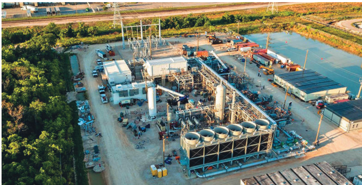
Рис. 6. Фото опытно-промышленной электростанции NET Power мощностью 50 МВт
