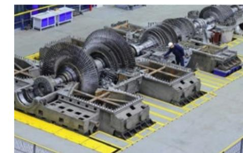
В конце 2018 года на энергоблоке ПГУ-420 ТЭЦ-20 ПАО «Мосэнерго» проведена расширенная инспекция горячего тракта газовой турбины. Энергоблок стал пилотным проектом концепции гибких межсервисных интервалов, благодаря внедрению которой Общество сможет сократить расходы на сервисное обслуживание оборудования и увеличить доходы от поставки электроэнергии и мощности.
