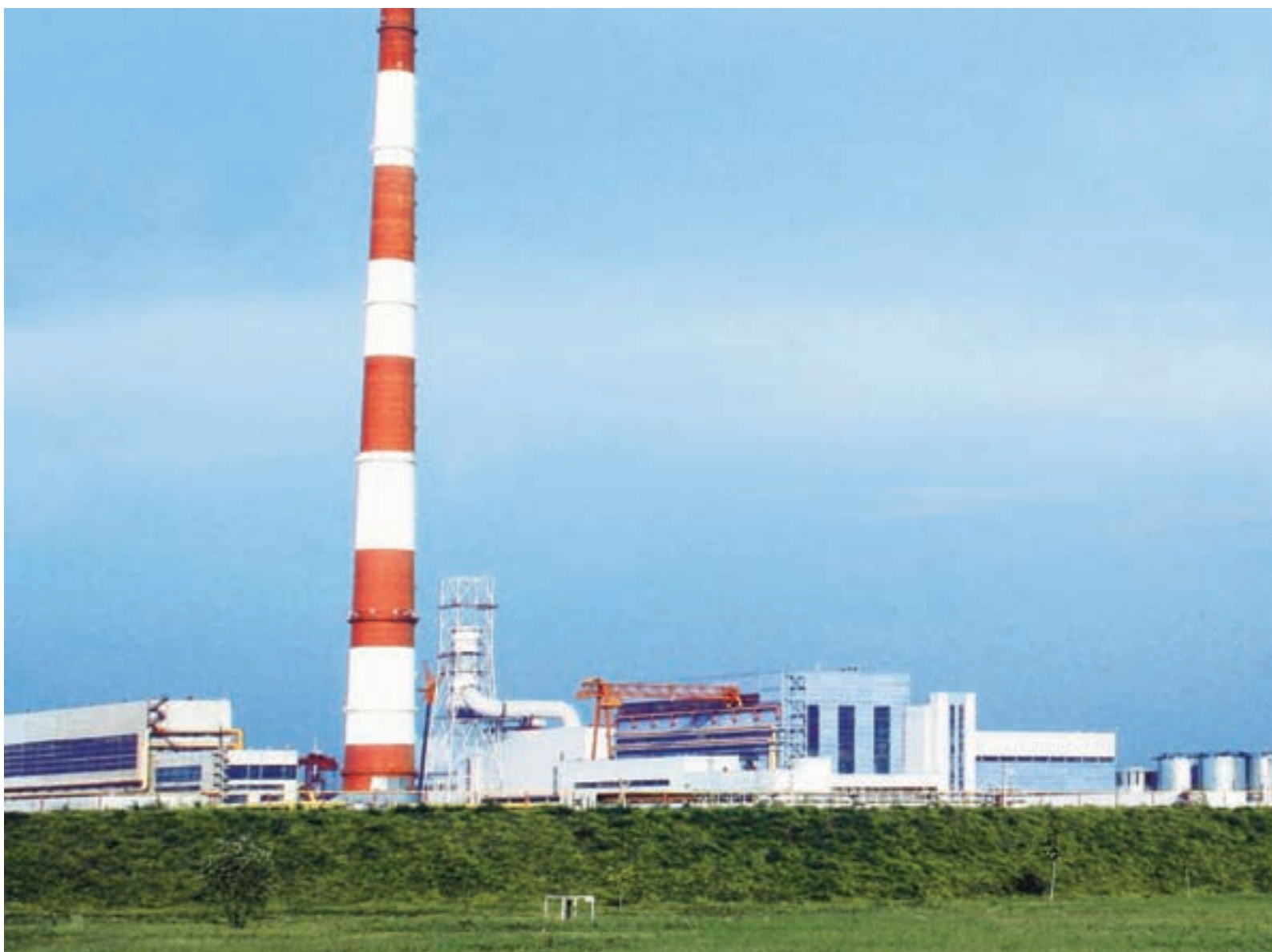
Комплекс производственных зданий и сооружений ТЭЦ-27 – корпус пиковых водогрейных котлов, дымовая труба, строящаяся дымовая труба, главный корпус, оборудование химического цеха (слева направо)
