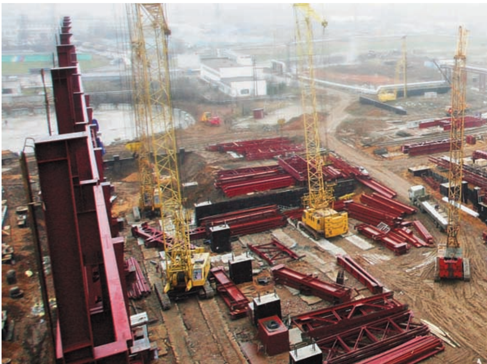
Строительство энергоблока № 11 ПГУ-450Т на ТЭЦ-21, январь 2007 года
