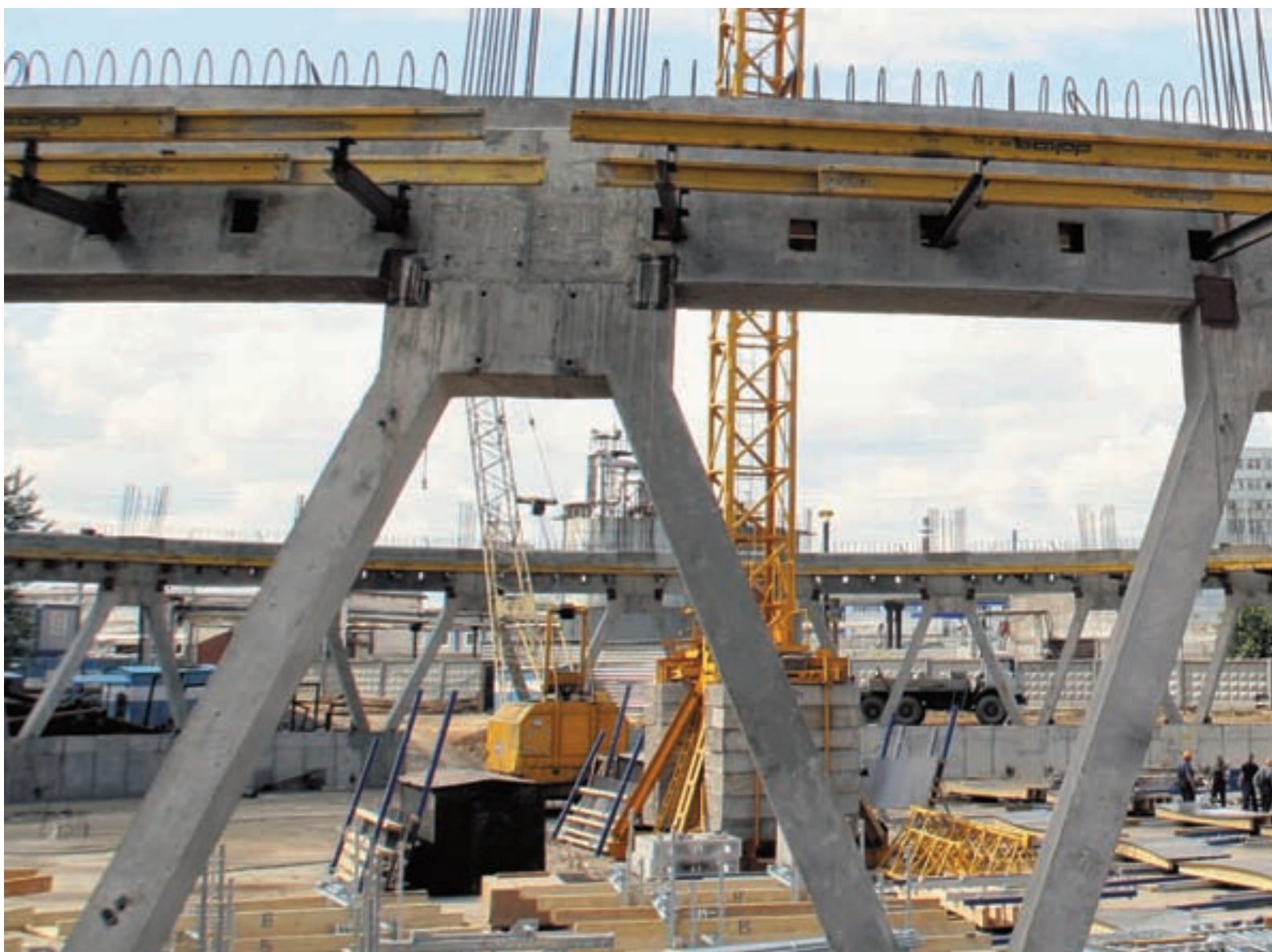
Строительство градирни энергоблока № 11 ПГУ-450Т на ТЭЦ-21, июнь 2007 года
