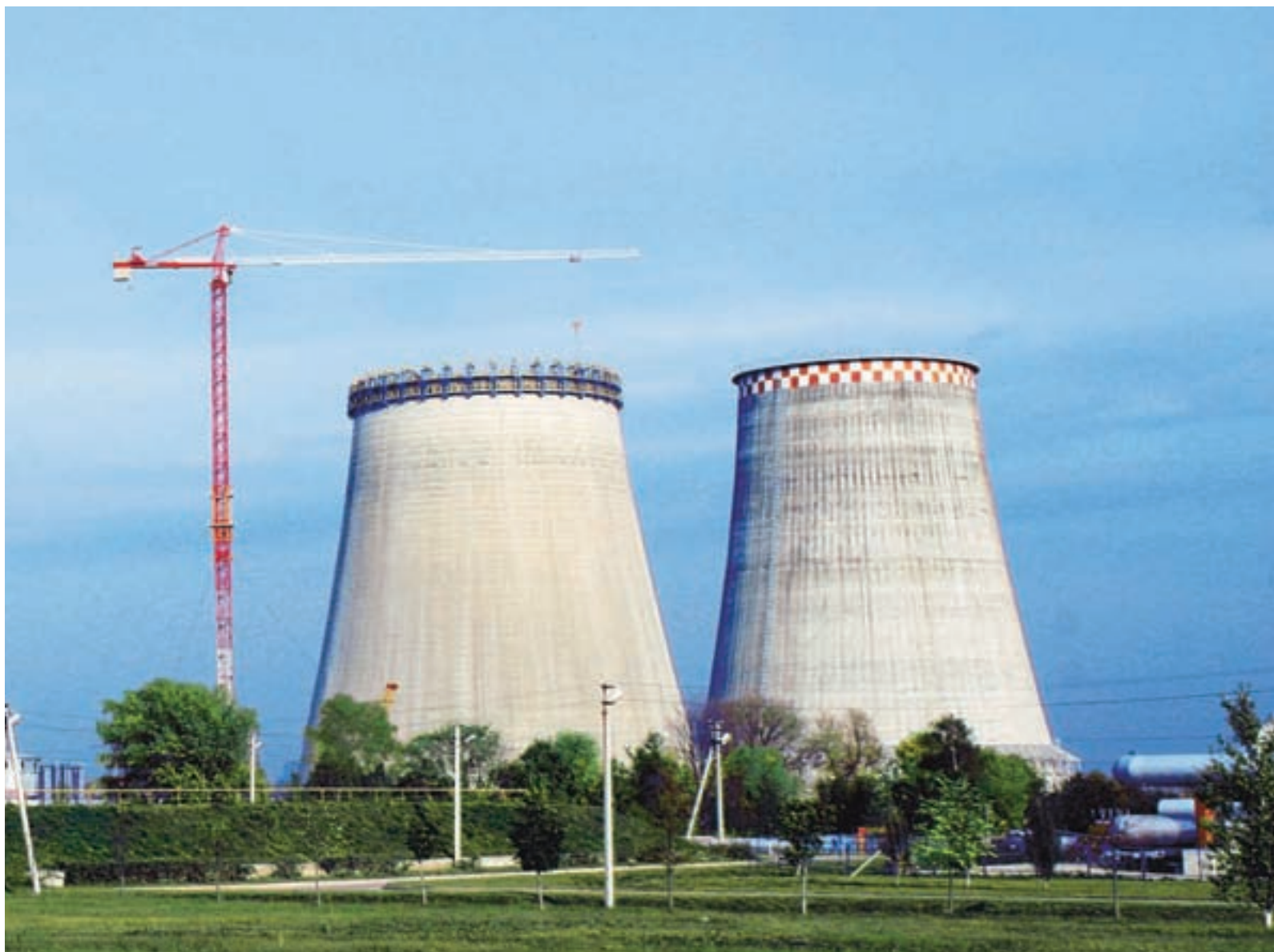
Корпус производственных зданий и сооружений ТЭЦ-27 – строящаяся и действующая градирни (слева направо)
