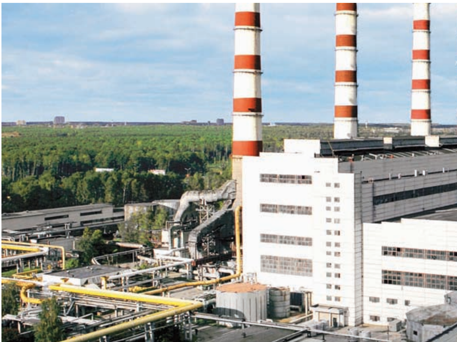
Общий вид главного корпуса № 1 ТЭЦ-21 – филиала ОАО «Мосэнерго»
