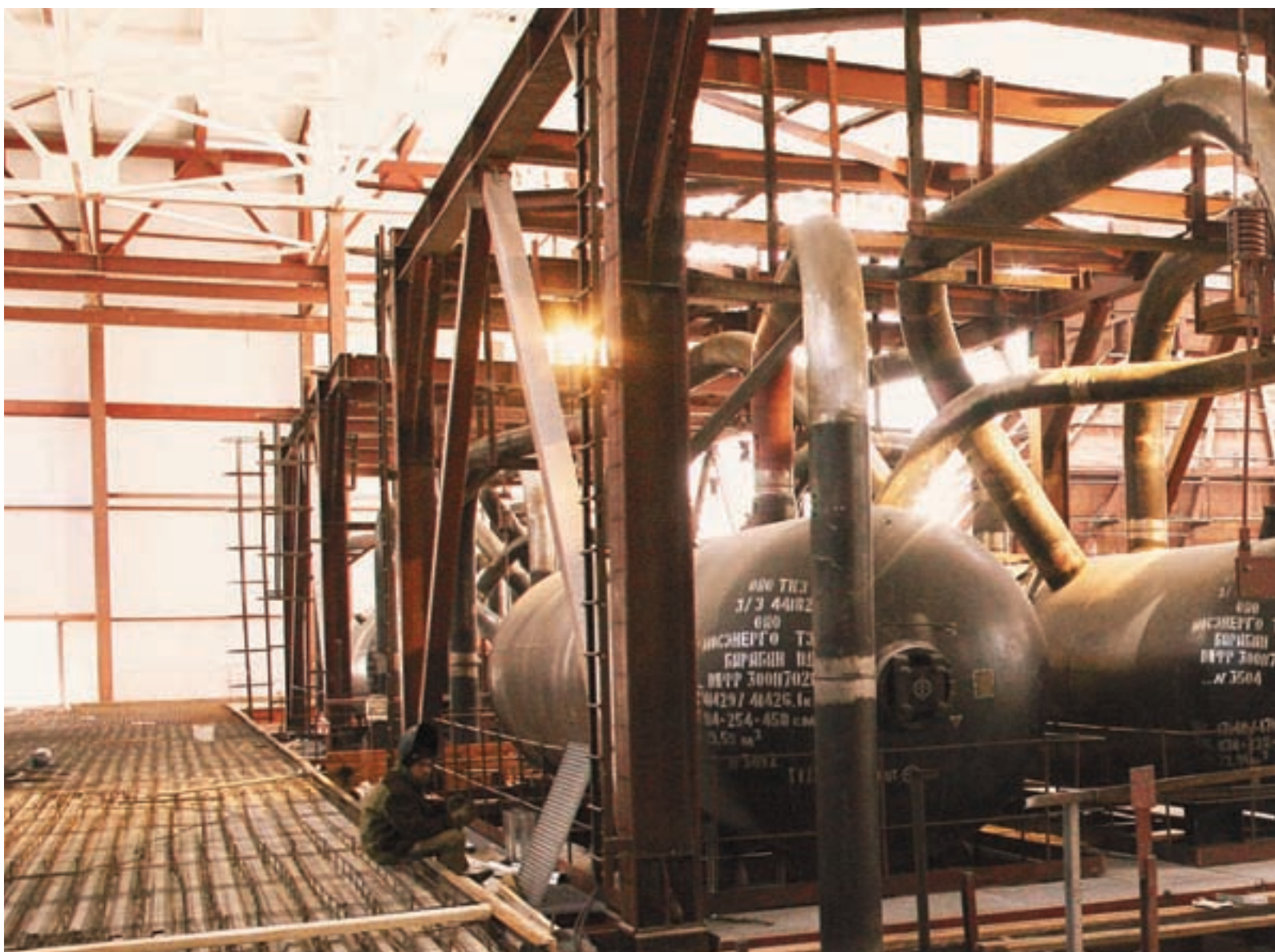
Монтаж котлов утилизаторов энергоблока № 11 ПГУ-450Т на ТЭЦ-21, сентябрь 2007 года
