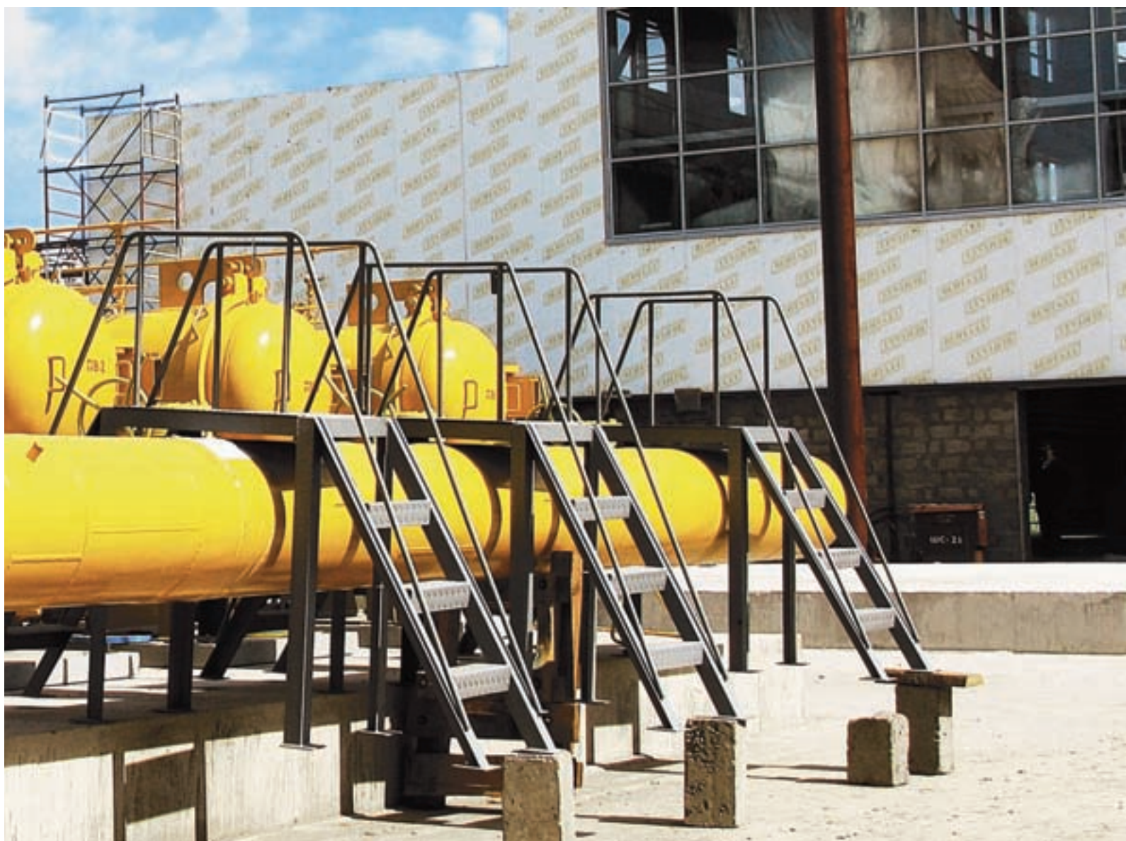
Дожимная газокompрессорная станция обеспечивает требуемое давление газа на входе в газовую турбину
