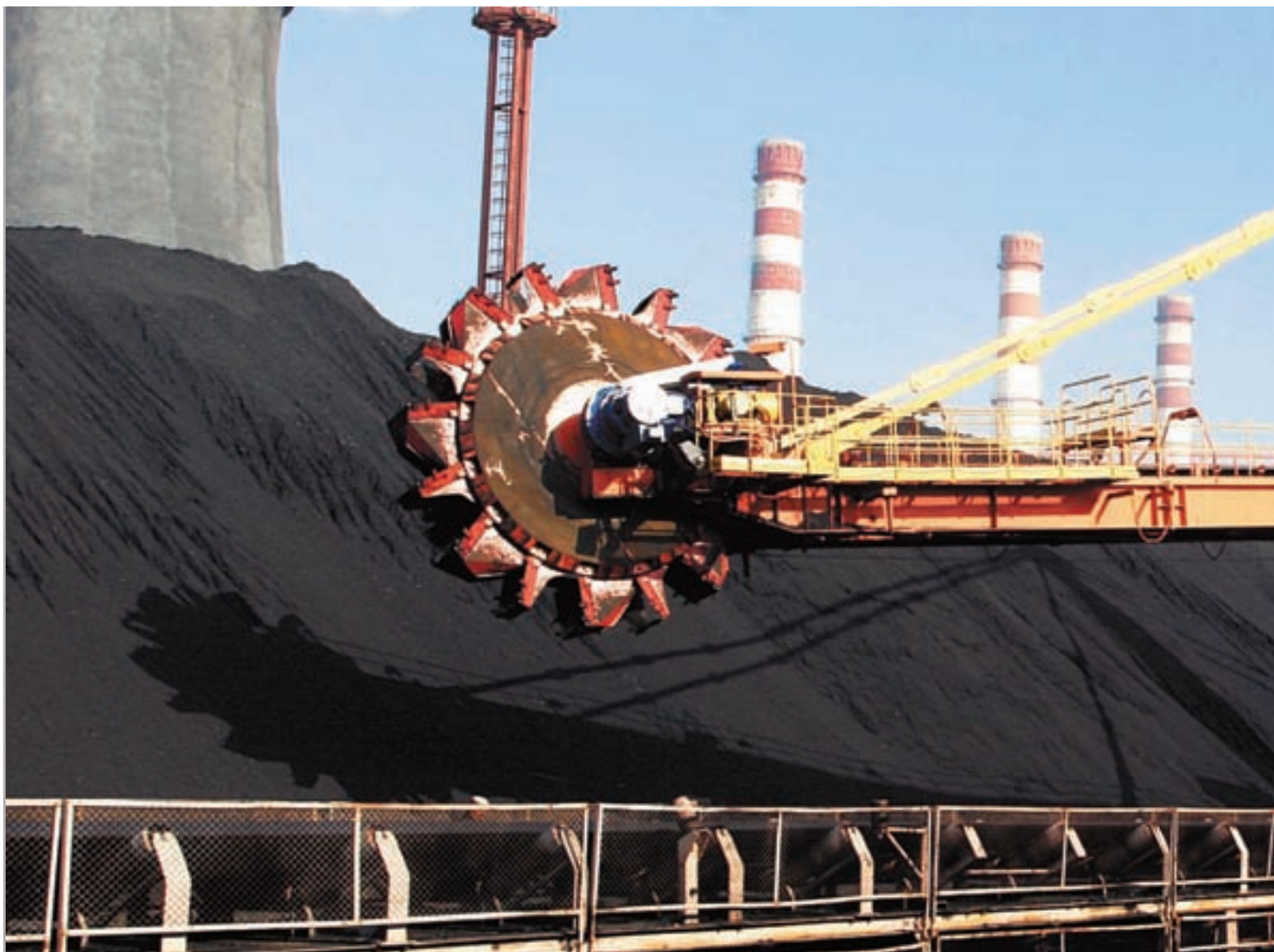
Угольный склад ТЭЦ-22, роторный укладчик-заборщик, март 2007 года
