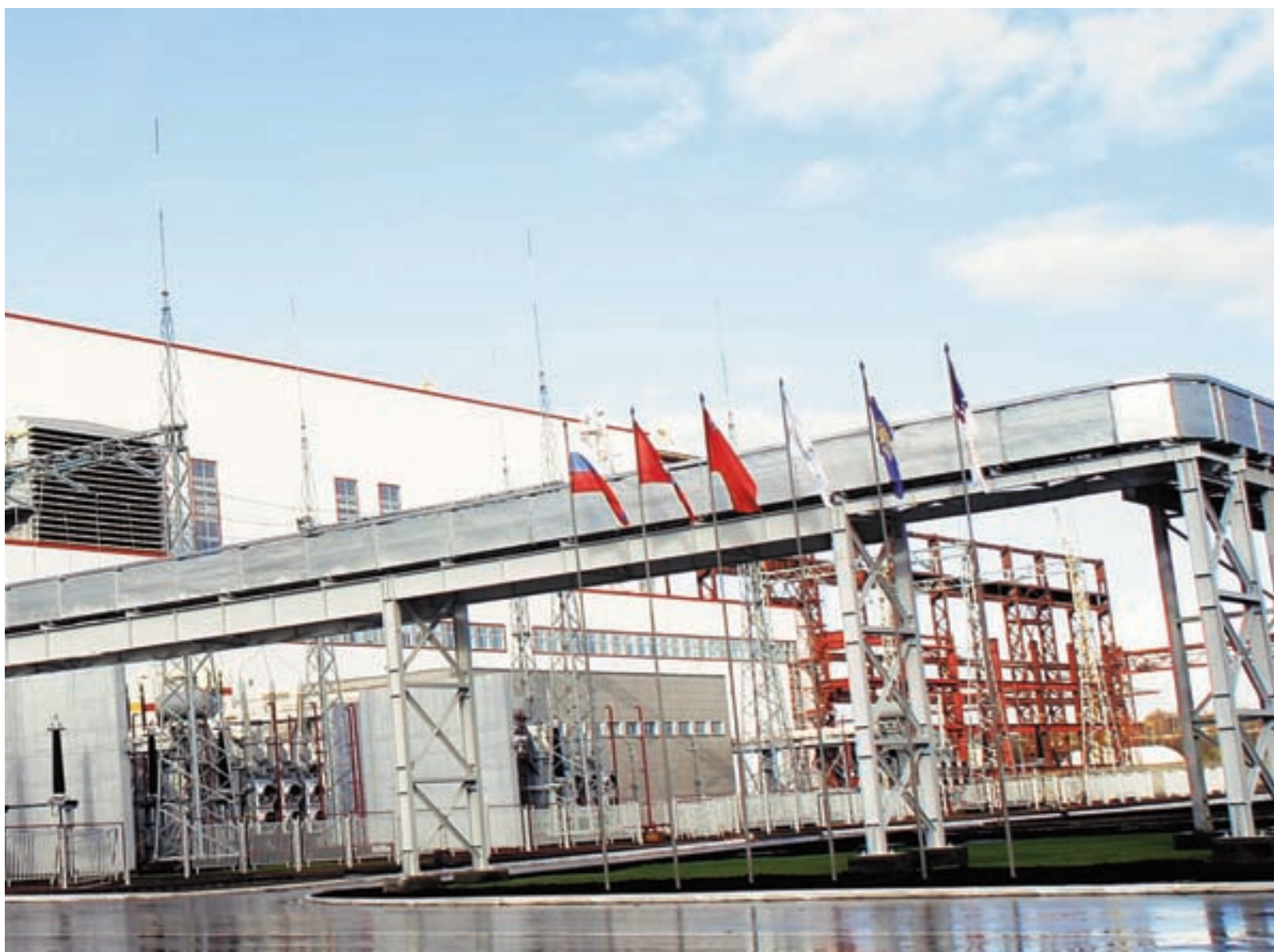
Главный корпус энергоблока № 3 ПГУ-450Т и пристанционный узел, монтаж главного корпуса энергоблока № 4 ПГУ-450Т
